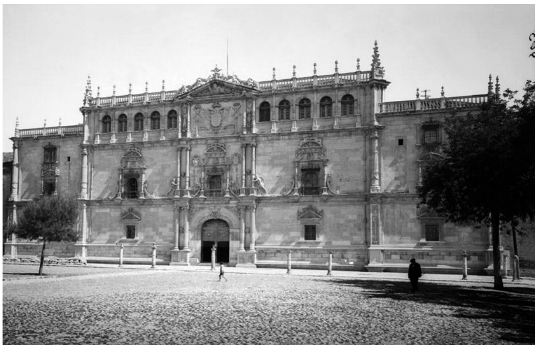
La fachada poco después de finalizar las intervenciones de Aníbal Álvarez, c. 1925 (Foto de Antonio Passaporte, Archivo Loty, Instituto del Patrimonio Cultural de España).
