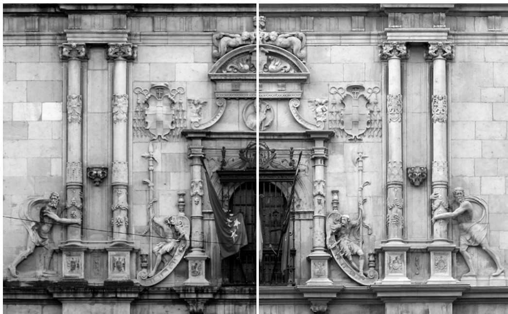
Comparación del estado de origen (izquierda) con el restaurado (derecha), en el ventanal central de la antigua biblioteca, 2017 (Fotos del autor).
