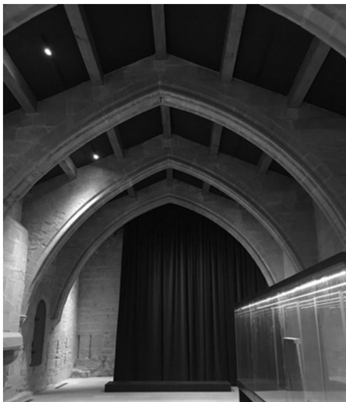
Unidad de actuación UA 1.1. Reestructuración del conjunto museístico, intervenciones en el dormitorio de conversos-sala del Abad Mengucho (s. XIII) y en la sala del Abad Copnos (s. XIV).
