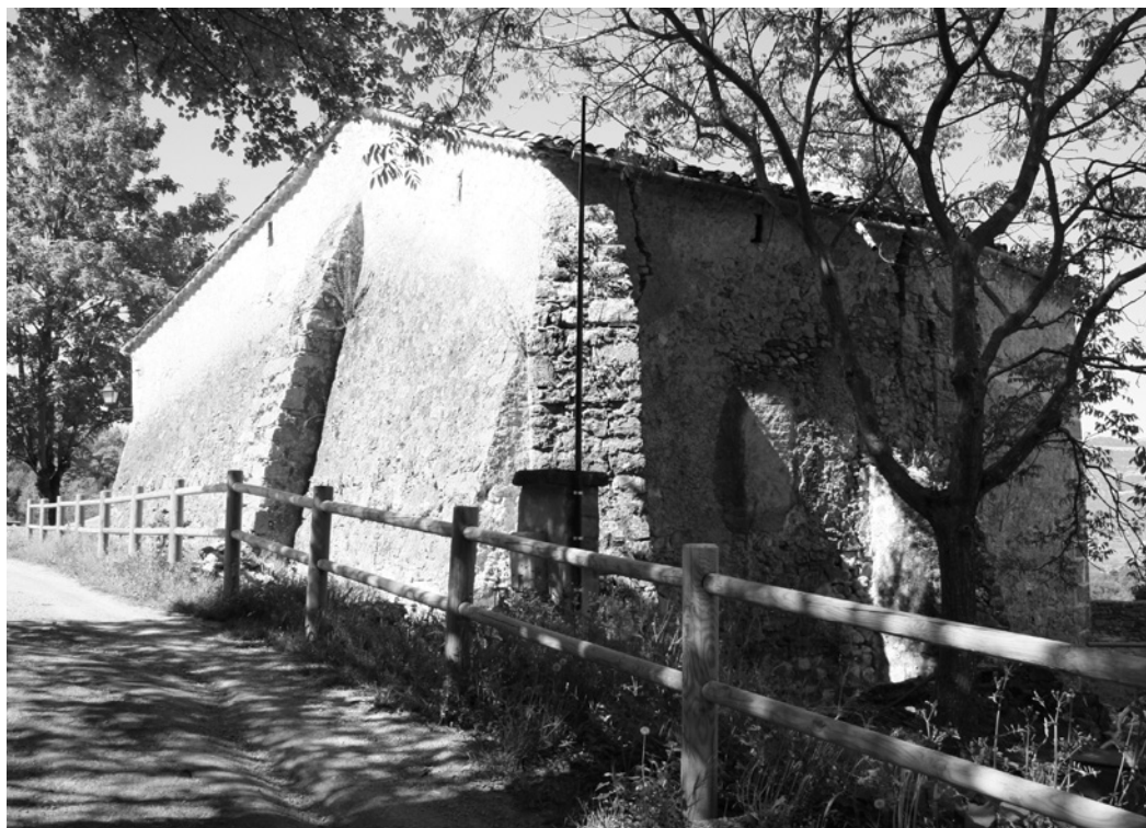
Imagen del muro y contrafuertes en fachada este.
