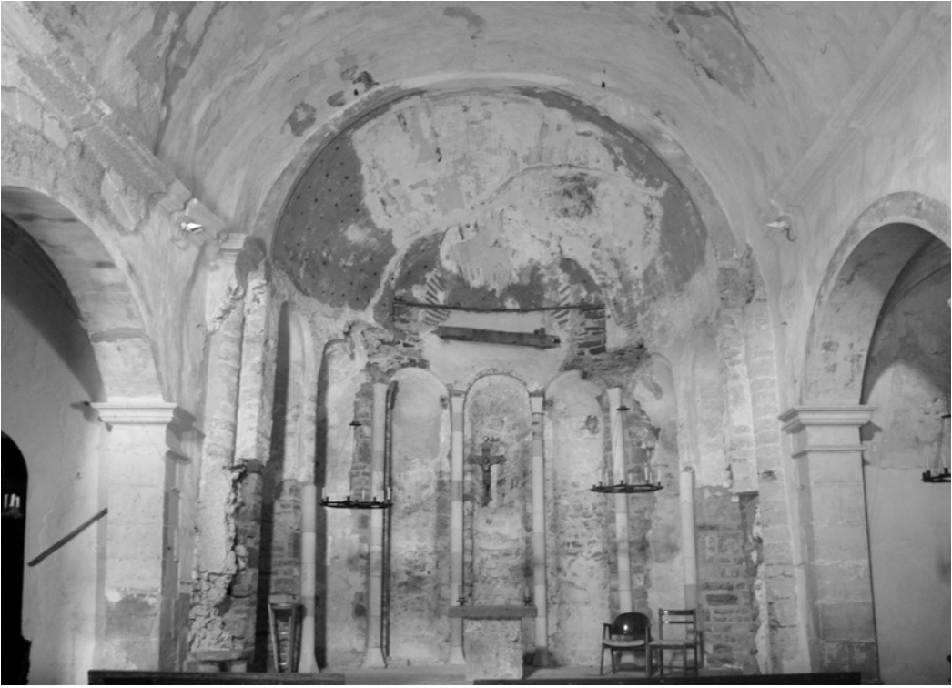
Imagen desde la nave del ábside principal y del acceso a las capillas norte y sur.
