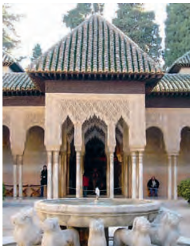
3. Estado actual de la fuente y el templo de Levante tras las obras realizadas (imagen de la autora).
