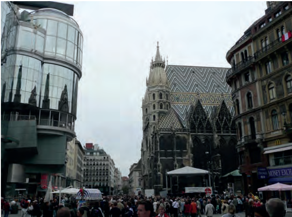
2. Inserción de arquitectura contemporánea en el centro histórico de Viena (imagen del autor).
