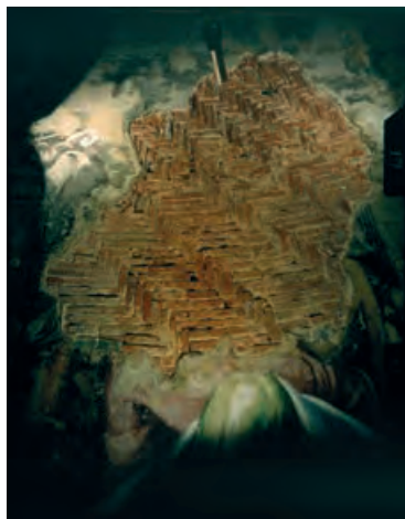
13 e 14. La straordinaria apparecchiatura muraria intradosale che è venuta alla luce a seguito di alcuni 'stacchi' degli intonaci pittorici. Essa ha rivelato novità di enorme interesse storico e tecnico.
