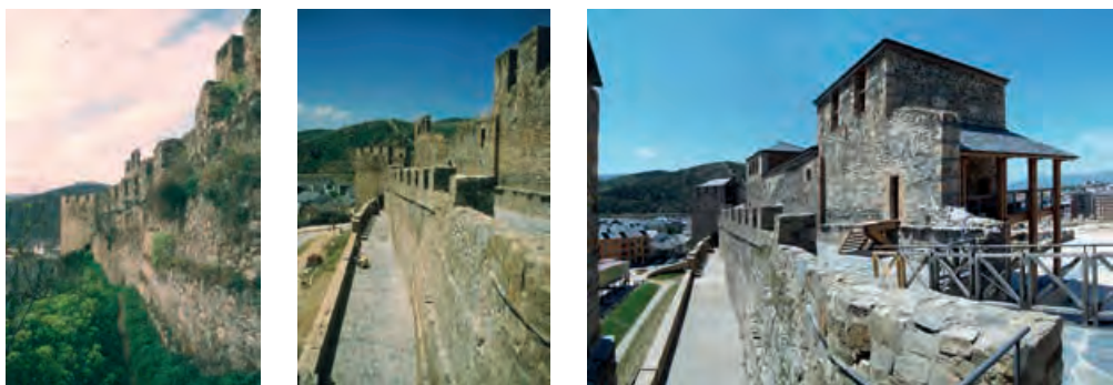
15. Castillo de Ponferrada. Estado inicial, tras las obras de consolidación (1998-2000) y estado actual de la ronda baja y la ronda alta del frente sur (imágenes del autor).
