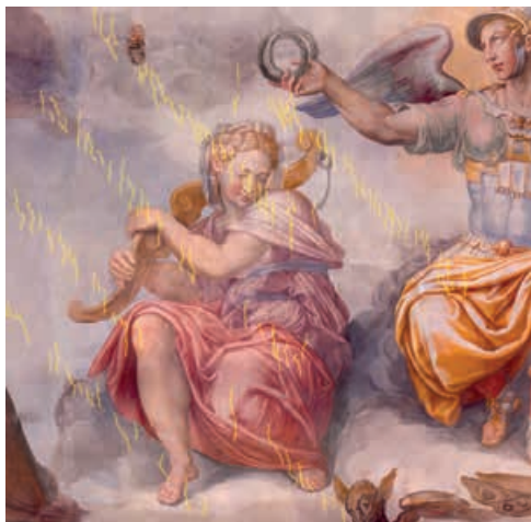
11 e 12. I depositi di sporco si erano maggiormente addensati in corrispondenza delle microlesioni degli intonaci pittorici. Sulla base dell'analisi fotografica eseguita nel corso dei lavori è stato possibile individuare l'andamento dei ricorsi di mattoni verticali del sistema 'spinapesce', proprio grazie a tali depositi, poi dissolti dopo le prime operazioni di pulitura della superficie pittorica.
