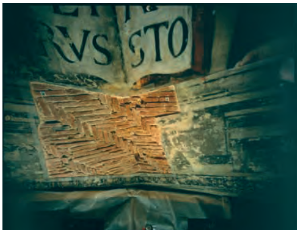
13 e 14. La straordinaria apparecchiatura muraria intradosale che è venuta alla luce a seguito di alcuni 'stacchi' degli intonaci pittorici. Essa ha rivelato novità di enorme interesse storico e tecnico.
