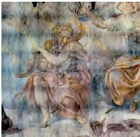
11 e 12. I depositi di sporco si erano maggiormente addensati in corrispondenza delle microlesioni degli intonaci pittorici. Sulla base dell'analisi fotografica eseguita nel corso dei lavori è stato possibile individuare l'andamento dei ricorsi di mattoni verticali del sistema 'spinapesce', proprio grazie a tali depositi, poi dissolti dopo le prime operazioni di pulitura della superficie pittorica.
