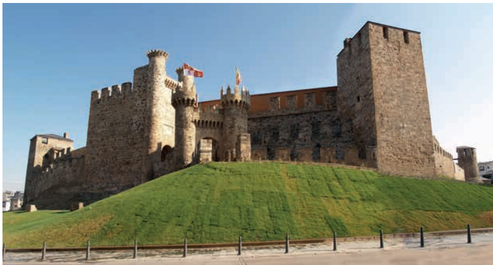
2. Castillo de Ponferrada. Estado actual de la fachada de la puerta principal (imagen del autor).
