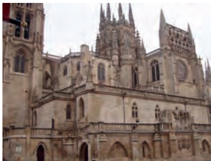
4. Las manchas se hacen visibles en todo el edificio (imagen de la autora).
