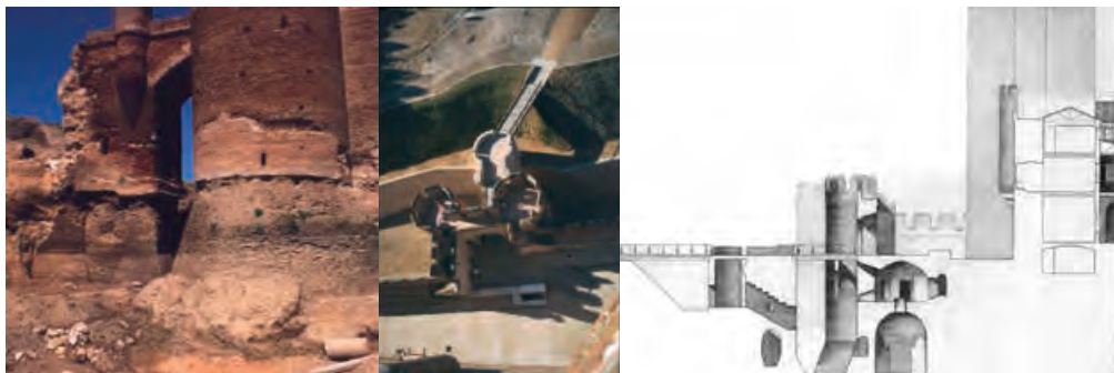
7. Castillo de la Mota. Restos del baluarte de antepuerta con el arco del puente de 1913 durante su excavación y vista aérea y sección del sistema de ingreso original ya recuperado (imágenes del autor).
