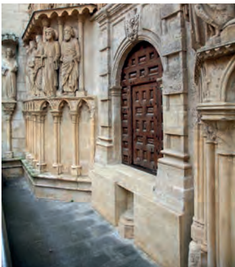
7. Inútil excavación bajo la puerta de Coronería (de acceso a la Escalera Dorada) y reinsertión de las columnillas de nueva factura que fueron eliminadas en el siglo XVI (imagen de la autora).
