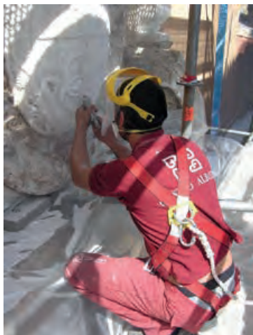
1. Limpieza de portada pétreo del palacio de Ágreda. Granada. Fotografía: Julia Ramos.
