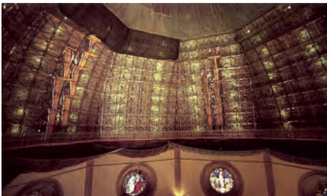
1 e 2. Veduta laterale e dal basso del grande ponteggio aereo sul quale fu allestito il cantiere di restauro della cupola (foto Soprintendenza per i Beni A e A. di Firenze).
