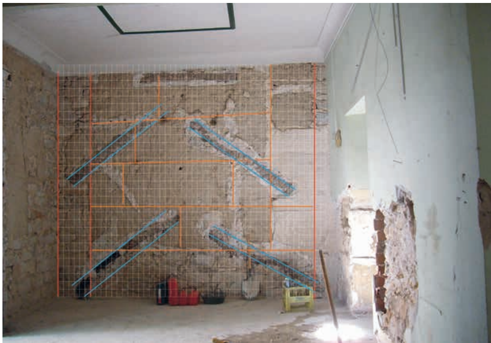
2. Levantamiento de estructura muraria. Fotografía: Pablo J. Gutiérrez Calderón.
