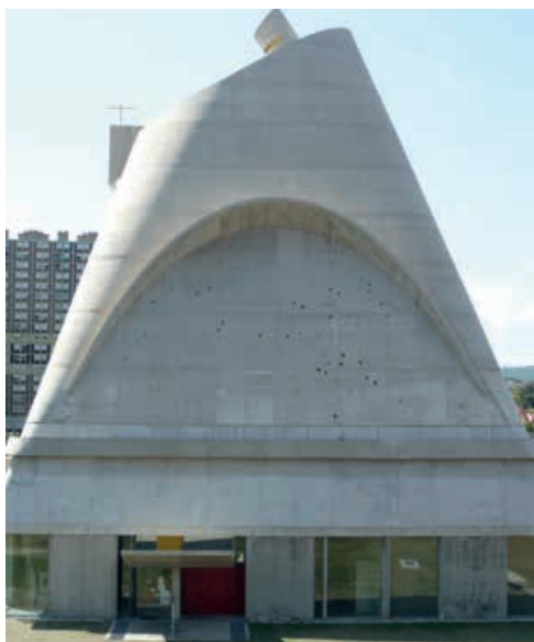
3. Eglise de Saint-Pierre en Firminy Vert. Concebida por Le Corbusier en los sesenta, la iglesia se empezó a construir tras su muerte, abandonándose la obra en 1978. No será hasta el período 1993-2006 en que se concluyan los trabajos, siendo evidentes las diferentes composiciones y apariencia del hormigón en la base y el resto del edificio (imagen de la autora).
