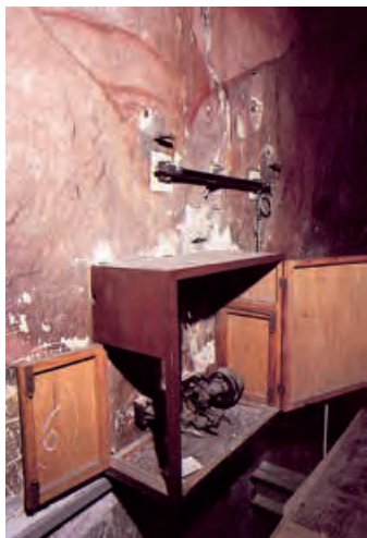
4. Le varie strumentazioni atte a misurare i movimenti delle lesioni della cupola, installate tra il 1934-35, nel 1950-1953 e nel 1984-1986 (foto dell'autore).
