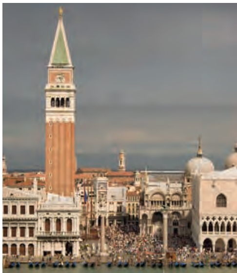
2. Campanile de San Marcos de Venecia. Reconstruido en 1912 tras su colapso, es el antecedente clásico de la restauración "com'era dov'era", legitimada posteriormente por la devastación sufrida por el patrimonio europeo durante la Segunda Guerra Mundial (imagen de la autora).
