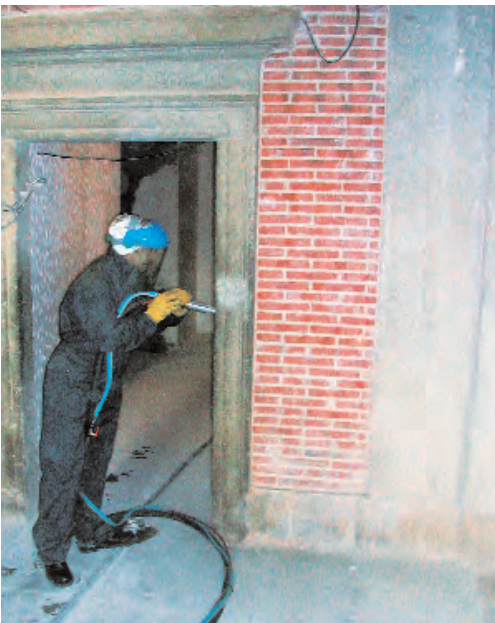
Mecánica abrasivos: Limpieza mecánica mediante proyección de abrasivos a baja presión de granito y ladrillo. Foto: Manuel Iglesias Campos, Virtudes Azorín López, María Isabel Sánchez de Rojas, Moisés Frías Rojas
