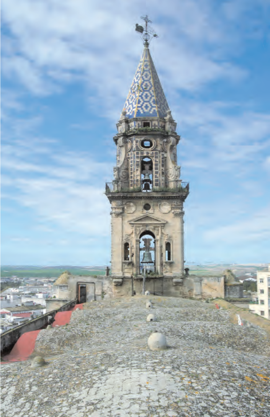
Cubiertas y torre de la Iglesia de San Miguel. Foto: Eugenio Fernández Ruiz
