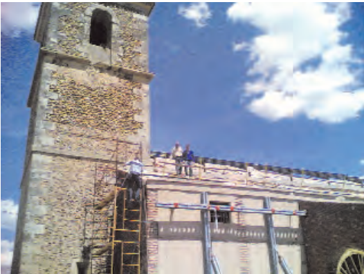
Exterior de la Parroquia de Malaguilla. Intervención Foto: Proyecto de Intervención
