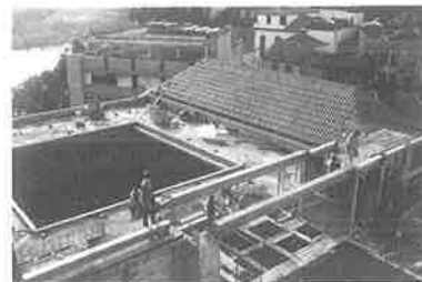
Desmonte de zonas em pré-colapso e identificação de paredes.
