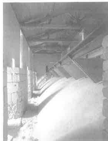
Nouveau plancher posé sur la voûte du xviii siècle, Photo: P. Ruault, 1999.
