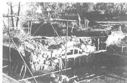
Reposição e consolidação de pedras da derrocada dos arcos a jusante.
