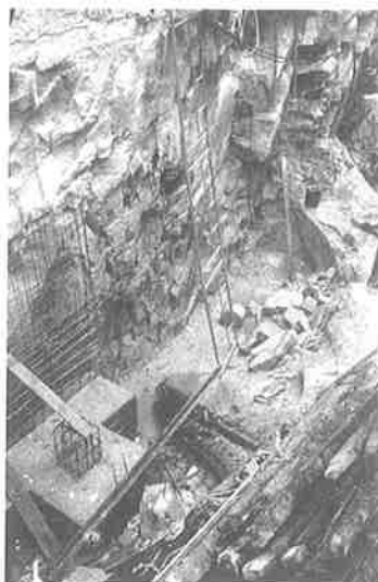
Execução de novas fundações.
