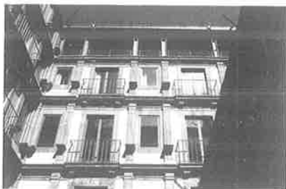
Claustro - volumetria reposta no 5.º Piso.
