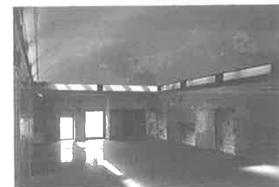
Aspecto final de Refeitório.
