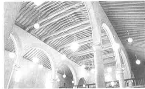
La nueva artesa de la nave principal y la solución de iluminación por globos suspendidos de una malla de cables. Foto: LyC.
