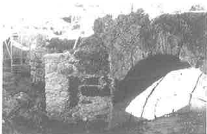
Reposição e consolidação da quilha do quebrão a montante.
