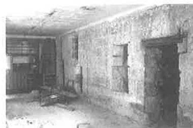
Reconstrução do edifício do século xix integralmente em aço.
