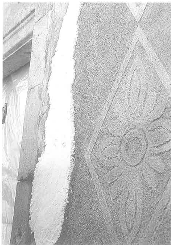
Aplicación de apósitos para la desalinización y limpieza de los revestimientos. Foto: J. Casadevall, 16.05.01.
