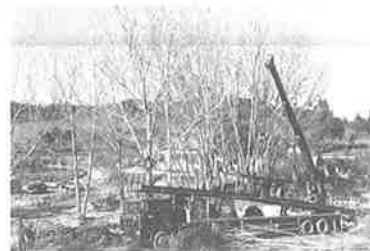
Transporte do novo tabuleiro em aço com 11 m de comprimento.
