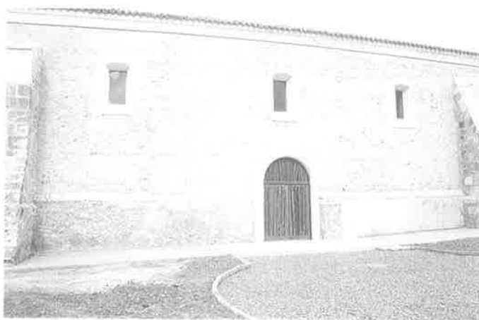
Detalles de la cantería caliza de Campaspero y de la carpintería de madera de haya y latón de las puertas y ventanas de la fachada sur, Foto: LyC.
