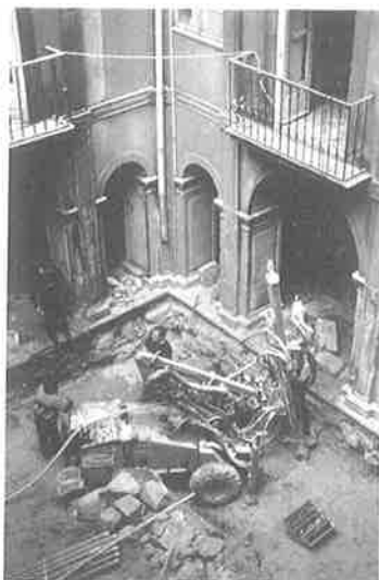
Perfuração para implantação de estacas.
