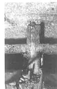
Ancoragem pré-existente do soalho.
