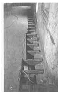
Soalho pré-existente e respectiva tecnologia.
