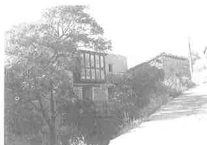
Fachada a la calle del Castillo después de la rehabilitación, con la pasarela de acceso y el mirador al castillo sobre la antigua solana. Fotos: P. Oteiza, junio 2000.
