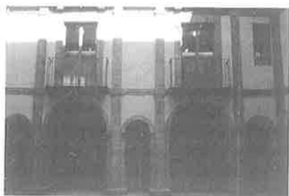
Claustro - Piso térreo.
