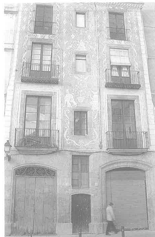
Fachada de Escudellers 44, conservando la integridad de los esgrafiados y materiales originales utilizando exclusivamente morteros y aguadas de cal grasa. Foto: J. Casadevall, 16.05.01.
