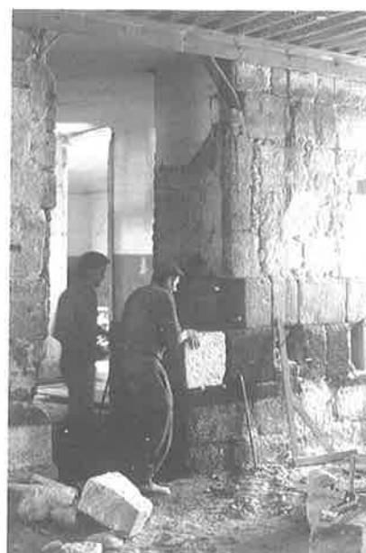
Reposicionamento de silhares de granito.
