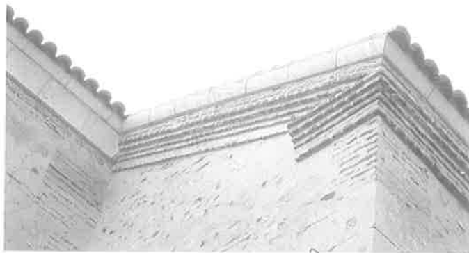
Ejecución de las cornisas con la distinta composición en función del contexto, Foto: LyC.
