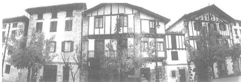
La LFOTU determina la conservación de las tipologías edificatorias y las parcelas de interés, así como de las constantes arquitectónicas de los núcleos urbanos. Casco urbano de Lesaca. Foto: J.L. Franchez.
