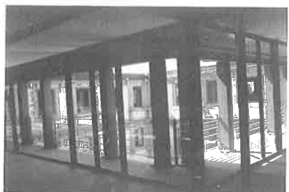
Claustro - volumetria reposta no, 5.º Piso.
