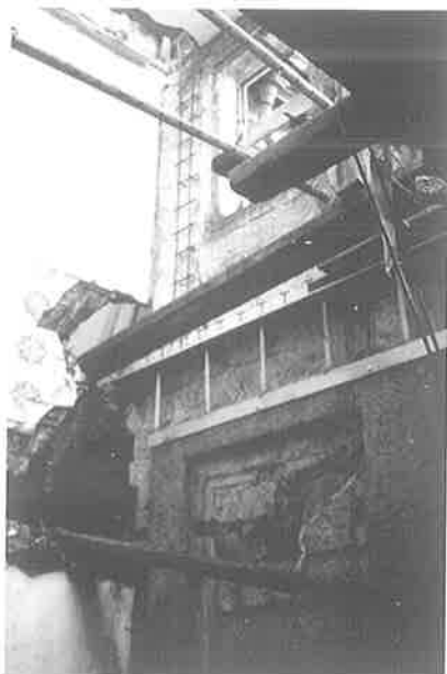
Detalhe de estrutura de consolidação das paredes.
