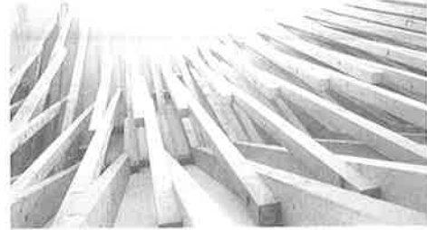
Superficies regladas obtenidas por la variación de las inclinaciones de los tirantes de las cerchas. Foto: LyC.
