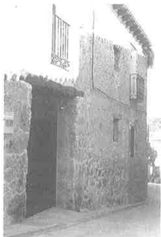
Fachada a la calle Real de la vivienda reformada. En la foto superior puede observarse el ventanal retranqueado. Fotos: P. Oteiza, junio 2000.
