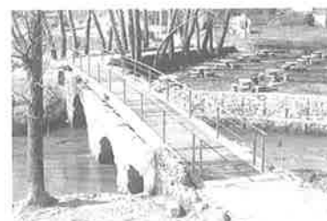
A Ponte integralmente reabilitada.
