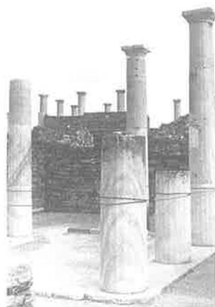
Anastilosi delle colonne in una delle case di Delos, senza alcuna integrazione. Foto: Stefano Gizzi, ottobre 1993.
