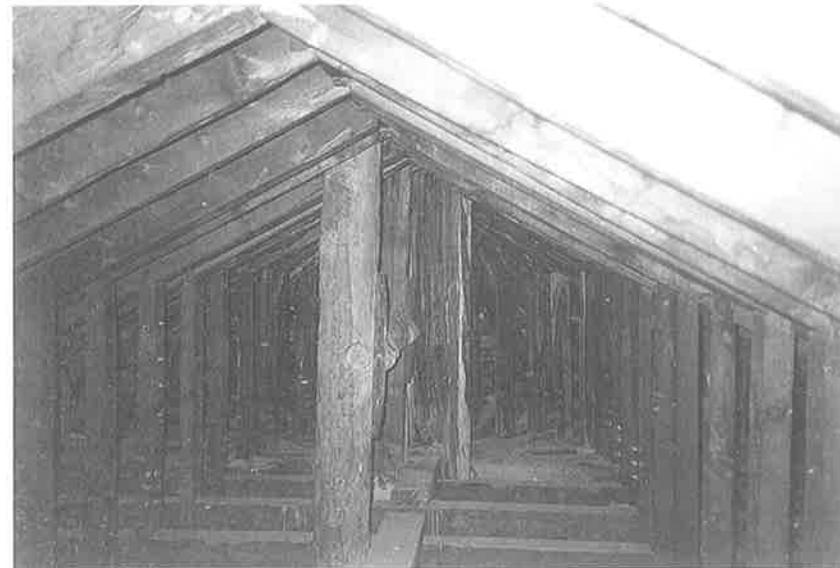
Estructura de la cubierta en la seo de Xàtiva, en la zona del ábside. Vista general del tramo superior. Foto: L. Palaia, 1999.
