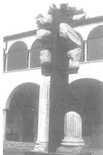
L'anastilosi «indiretta», su nuovi supporti metallici, di elementi corinzieggianti del Foro di Padova rimontati nel Museo Civico di Padova. Foto: Stefano Gizzi, giugno 1996.
