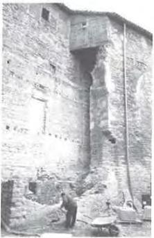
Fig. 9. Demolición arqueológica de una habitación construida a finales del siglo XIX y que se adosaba a las estructuras preexistentes de la Catedral y ocultaban la jamba de la puerta del primer recinto amurallado de la ciudad.
