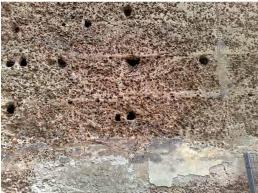
Fig. 10. Detalle de las cajas de las fábricas de tapial de cal y canto de la muralla del XII, en los muros reaprovechados del castillo (las agujas se observan bajo cada tongada y los mechinales que aparecen son de adosados posteriores).
