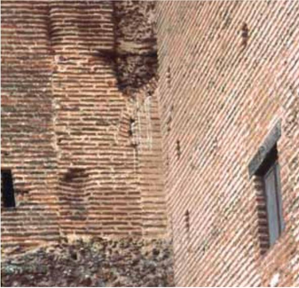
Fig. 15. Detalle del relevante con ladrillo del muro inicial de tapial, en el extremo este del castillo. El muro que se adosa perpendicularmente y por la izquierda pertenece a la etapa posterior de Enrique IV.
