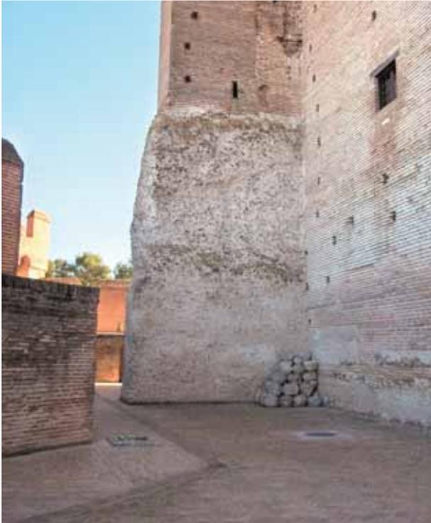
Fig. 5. Detalle de la muralla cortada al otro cabo del castillo con la gola de la torre del siglo XIV, rodeada y cerrada por la fábrica del castillo de Enrique IV cuyo muro principal se le adosa perpendicularmente.
