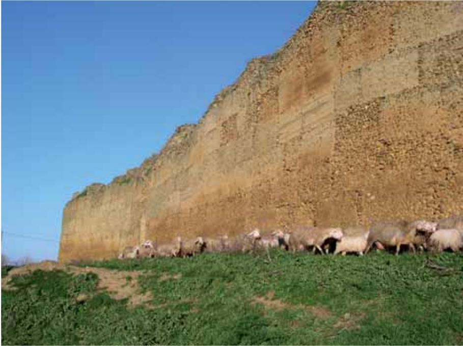
Fig. 11. Castillo de San Pedro de Latarce (Valladolid), recinto ovalado de tapias de cal y canto encofradas mediante un sistema de agujas pareadas de vara de fresno verde tensada; muros de 2,5 m. de ancho por 12 m. de alto.
