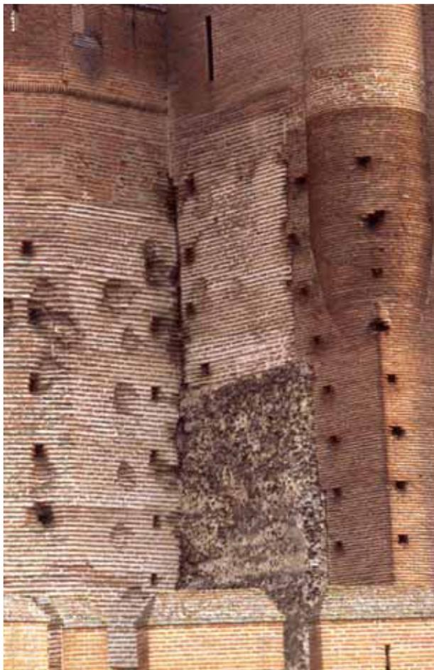
Fig. 4. Detalle torre puerta antigua donde se observa, de abajo arriba, la muralla de cal y canto, el adosamiento y relevante de Enrique IV con los impactos de artillería, el remate de la esquina de los Reyes Católicos (cuando cortan la muralla), el primer remate superior de la ruina por Agapito y Revilla en 1917 y el relevante de la restauración de Íñiguez Almech en 1943.
