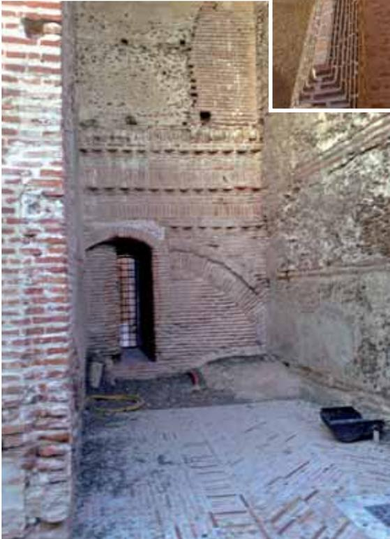
Fig. 14. Vista de la puerta mudéjar (en el muro del siglo XII), encajada y parcialmente tapadas sus jambas por dos torres de la etapa posterior.
