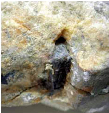
Fig. 13. Pàtina biològica de la pedra exposada a l'exterior. Fig. 14. Metall incrustat a la pedra. Fig. 15. Impactes de bala. Fig. 13. Pátina biológica de la piedra expuesta en exterior. Fig. 14. Metal incrustado en piedra. Fig. 15. Impactos de bala
