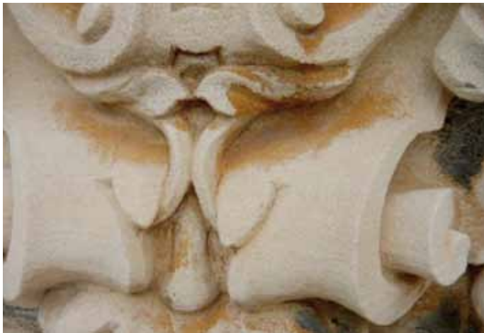
Fig. 32 Restes de capa pictòrica. Fig. 33. Després del procés de sanejament. Fig. 32 Restos de capa pictórica. Fig. 33. Después del proceso de resane
