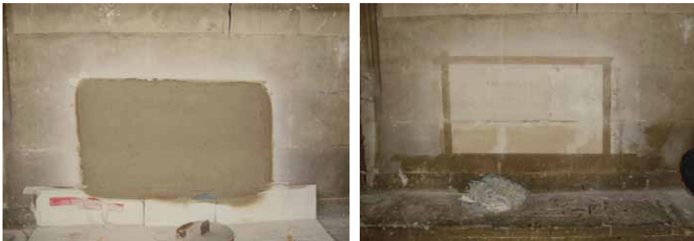
Fig. 25 i 26. Procés de neteja amb Pappeta. Fig. 25 y 26. Proceso de limpieza con Pappeta
