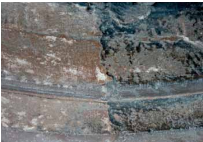
Fig. 8. Cata de neteja. Fig. 9. Durant la neteja. Fig. 8. Cata de limpieza. Fig. 9. Durante la limpieza
