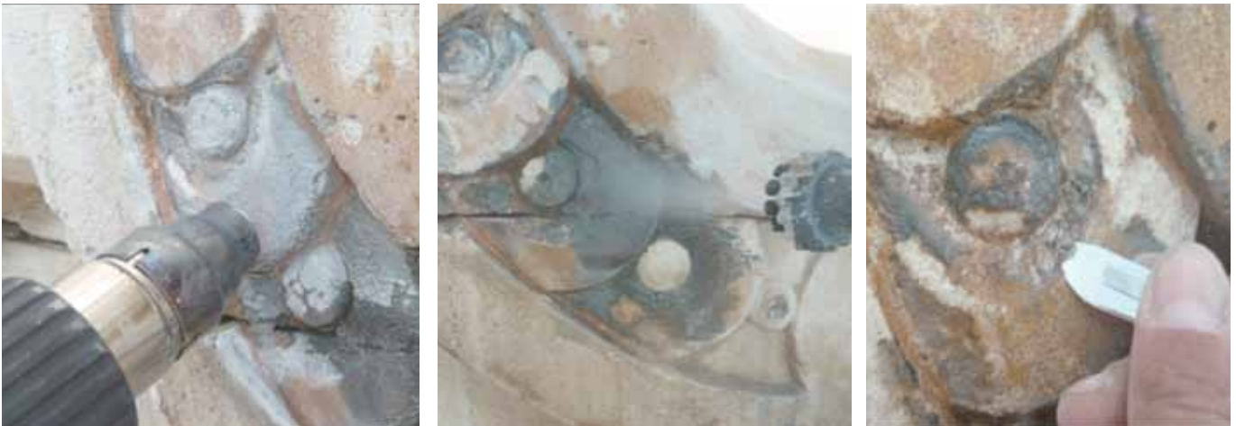
Fig. 15. Aplicació de calor. Pot observar-se com la brutícia adquireix un to blanquinós amb la temperatura. Fig. 16. Aplicació de vapor. Fig. 17. Eliminació de brutícia amb bisturí. Fig. 15. Aplicación de calor. Puede observarse como la suciedad adquiere un tono blanquizco con la temperatura. Fig. 16. Aplicación de vapor. Fig. 17. Eliminación de suciedad con bisturí
