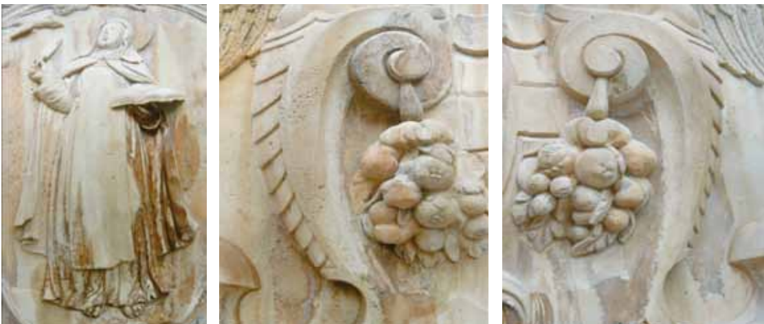
Fig. 20. Relleu de santa Teresa després de la neteja. S'observen restes de capa pictòrica. Fig. 21. Coa d'àngel esquerra després de la neteja. Fig. 22. Coa d'àngel dreta, a les fruites s'observen els recubriments amb morter que s'han fet. Fig. 20. Relieve de sta. Teresa después de la limpieza. Se observan los restos de capa pictórica. Fig. 21. Cola de ángel izq. después de la limpieza. Fig. 22. Cola de ángel derecha en las frutas se observan los recubrimientos con morteros realizados
