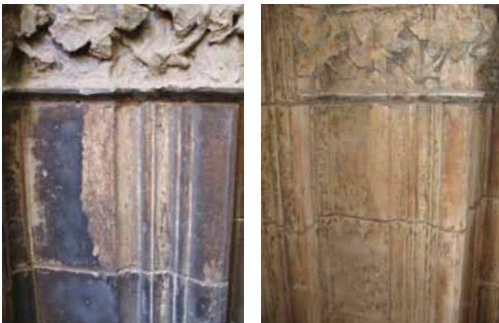
Fig. 10 i 11. Abans i després de la neteja de part del muntant, s'observen restes de pàtina respectades per la neteja. Fig. 10 i 11. Antes y después de la limpieza de parte de la jamba observándose restos de pátina respetados por la limpieza
