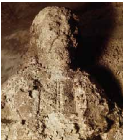
Fig. 3. Detall de l'alteració de la pedra en la portada de Ripoll, any 1964. Es noten les crostes que s'han format i a la superfície hi ha una pàtina de color marró feta amb guix. Fig. 4. Fotomicrografia 400x, làmina prima, il·luminació mixta. Anàlisi de la pàtina de Ripoll. Sobre la pedra arenisca (estrat 1), hi apareix la pàtina (estrat 2) feta amb guix i pedra triturada. Fig. 3. Detalle de la alteración de la piedra en la portada de Ripoll, año 1964. Nótese las costras formadas mostrando en la superficie una pátina de color pardo a base de yeso. Fig. 4. Fotomicrografía 400x, lámina delgada, iluminación mixta. Análisis de la pátina de Ripoll. Sobre la piedra arenisca (estrato 1), aparece la pátina (estrato 2) a base de yeso y piedra triturada
