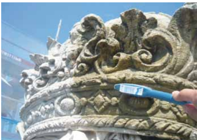
Fig. 34. Durant la neteja. Fig. 35. Escut reial després del procés de sanejament. Fig. 34. Durante la limpieza. Fig. 35. Escudo real después del proceso de resane
