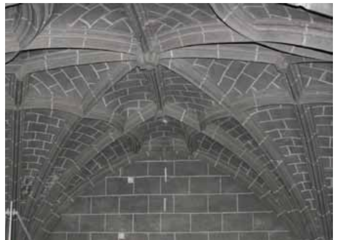
Fig. 8. Obra i revestiment d'Alonso González del s. XVI, recuperats en la actual restauració. Fig. 9. Revestiment del s. XIX. Fig. 8. Obra y revestimiento de Alonso González, del s. XVI, recuperados en la actual restauración. Fig. 9. Revestimiento del s. XIX.
