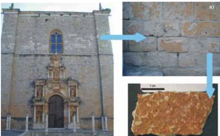
Fig. 1. Imatges que mostren la col·legiata de Peñaranda de Duero, un detall de la façana i un de la pàtina. Fig. 1. Imágenes que muestran la Colegiata de Peñaranda de Duero, un detalle de su fachada y un detalle de la pátina
