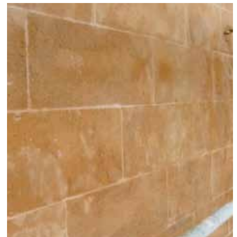
Fig. 16. Aplicació de la pàtina. Fig. 17. La imatge mostra el to del parament abans de la pàtina i després de l'aplicació, així com restes de policromia original. Fig. 18. Aspecte final del parament. Fig. 16. Aplicación de la pátina. Fig. 17. La imagen muestra el tono del paramento antes de la pátina y después de la aplicación, así como restos de policromía original. Fig. 18. Aspecto final del paramento
