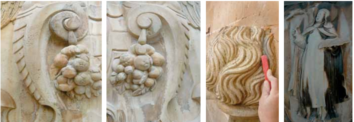
Fig. 47 i 48. Coes d'àngel després de la neteja. A les fruites s'observen els recobriments amb els morters que s'han fet. Fig. 49. Neteja química de torxa. Fig. 50. Relleu de santa Teresa després de la neteja. S'observen les restes de la capa pictòrica. Fig. 47 y 48. Colas de ángel después de la limpieza. En las frutas se observan los recubrimientos con morteros realizados. Fig. 49. Limpieza química de antorcha. Fig. 50. Relieve de Sta. Teresa después de la limpieza. Se observan los restos de la capa pictórica
