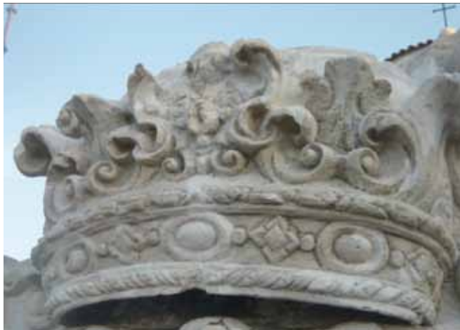
Fig. 32 Restes de capa pictòrica. Fig. 33. Després del procés de sanejament. Fig. 32 Restos de capa pictórica. Fig. 33. Después del proceso de resane
