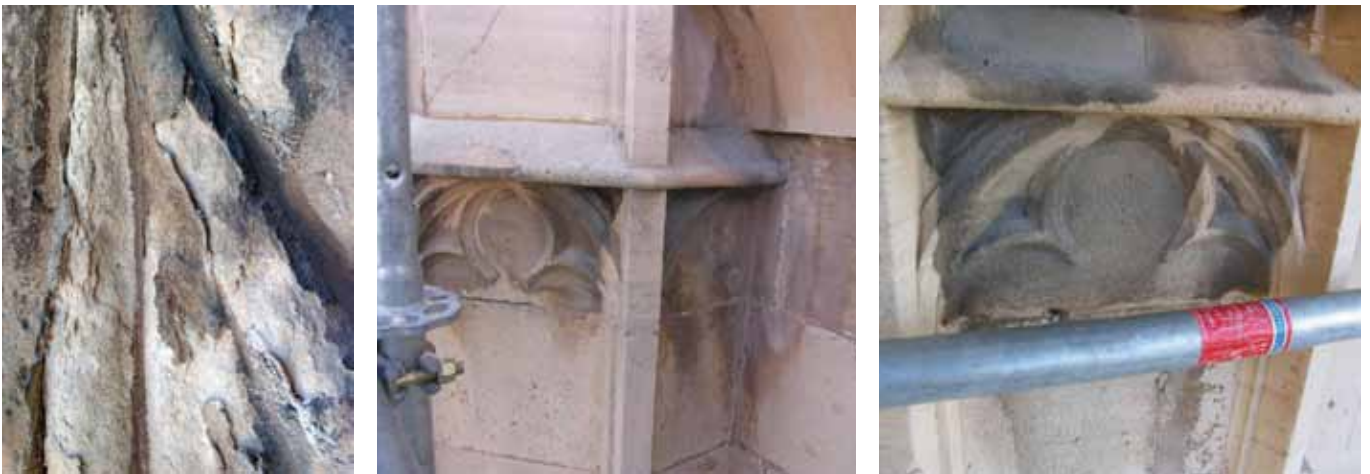
Fig. 19 Degradació als plecs d'una túnica. Fig. 20 i 21. Brutícia incrustada. Fig. 19. Degradación en los pliegues de una túnica. Fig. 20 y 21. Suciedad incrustada
