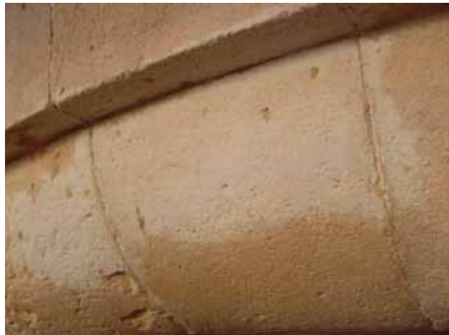
Fig. 14 i 15. Procés de desintegració de guixos i brutícia mitjançant deshidratació tèrmica. Fig. 14 y 15. Proceso de desintegración de yesos y suciedad por medio de deshidratación térmica
