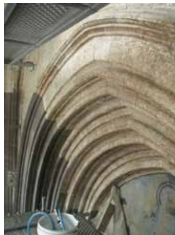
Fig. 19,20 i 21. Proves de neteja mitjançant projecció d'àrid a pressió controlada. Portal lateral esquerre. Fig. 19,20 y 21. Pruebas de limpieza mediante proyección de árido a presión controlada. Portal lateral izquierdo
