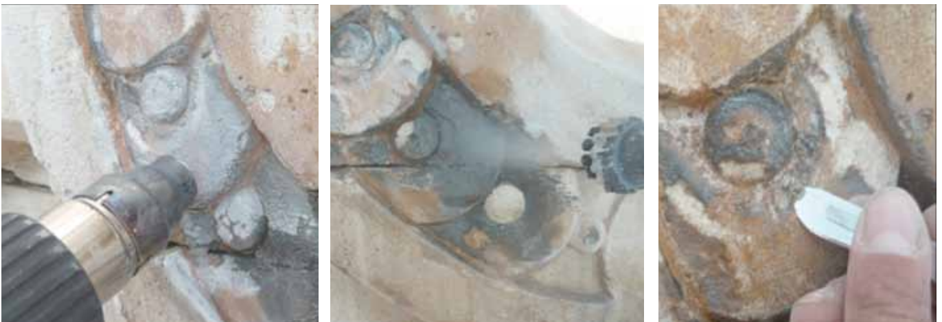
Fig. 42. Aplicació de calor. Pot observar-se com la brutícia adquireix un to blanquinós amb la temperatura. Fig. 43. Aplicació de vapor. Fig. 44. Eliminació de brutícia amb bisturí. Fig. 42. Aplicación de calor. Puede observarse como la suciedad adquiere un tono blanquizco con la temperatura. Fig. 43. Aplicación de vapor. Fig. 44. Eliminación de suciedad con bisturí.
