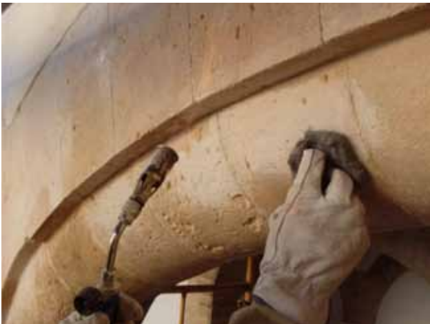
Fig. 14 i 15. Procés de desintegració de guixos i brutícia mitjançant deshidratació tèrmica. Fig. 14 y 15. Proceso de desintegración de yesos y suciedad por medio de deshidratación térmica
