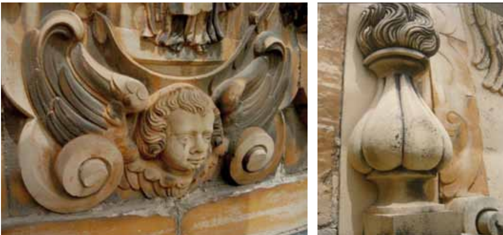
Fig. 3. Crosta de contaminació i capa pictòrica. Fig. 4. Presència de microorganismes. Fig. 3. Costra de contaminación y capa pictórica. Fig. 4. Presencia de microorganismos
