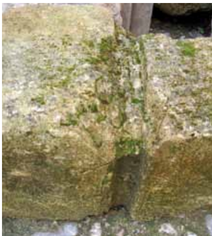
Fig. 13. Pàtina biològica de la pedra exposada a l'exterior. Fig. 14. Metall incrustat a la pedra. Fig. 15. Impactes de bala. Fig. 13. Pátina biológica de la piedra expuesta en exterior. Fig. 14. Metal incrustado en piedra. Fig. 15. Impactos de bala
