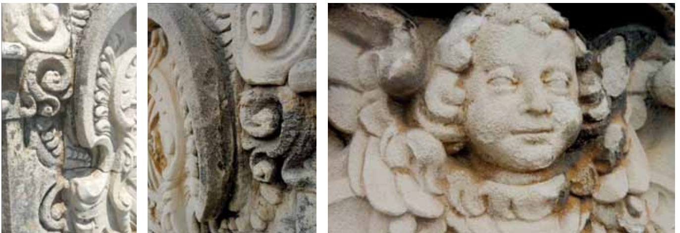
Fig. 29. Presència de microorganismes. Fig. 30. Detall de microorganismes. Fig. 31. Abans del procés, restes de capa pictòrica. Fig. 29. Presencia de microorganismos. Fig. 30. Detalle de microorganismos. Fig. 31. Antes del proceso, restos de capa pictórica
