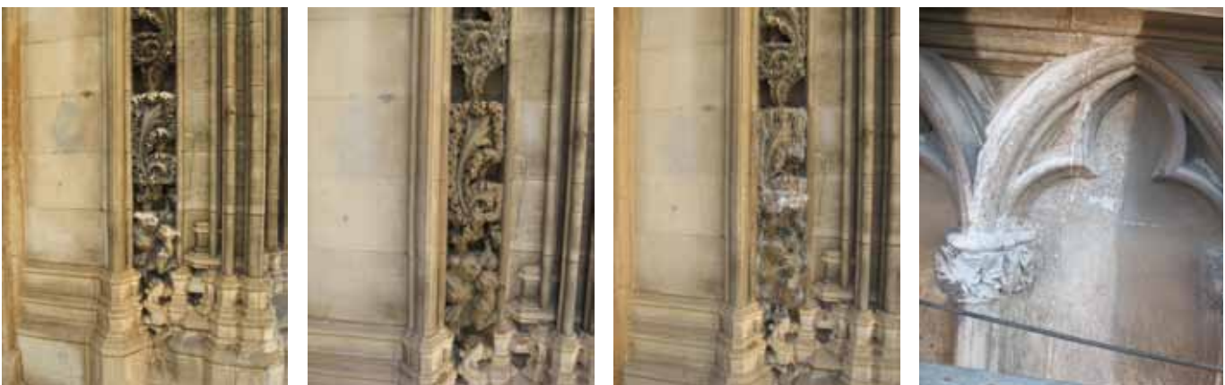
Fig. 12,13,14 i 15. Proves de neteja amb apòsits. Portal principal. Proves de neteja amb projecció de microabrasiu. Portal principal. Fig. 12,13,14 y 15. Pruebas de limpieza con apósites. Portal principal. Pruebas de limpieza con proyección de microchorro. Portal principal.
