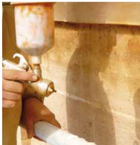
Fig. 16. Aplicació de la pàtina. Fig. 17. La imatge mostra el to del parament abans de la pàtina i després de l'aplicació, així com restes de policromia original. Fig. 18. Aspecte final del parament. Fig. 16. Aplicación de la pátina. Fig. 17. La imagen muestra el tono del paramento antes de la pátina y después de la aplicación, así como restos de policromía original. Fig. 18. Aspecto final del paramento
