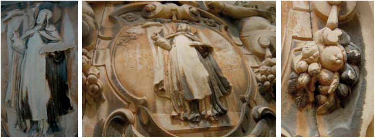
Fig. 8. Detall abans de la neteja. Fig. 9. Escut de santa Teresa amb restes de capa pictòrica. Fig. 10. Detall de crosta de contaminació als relleus i pèrdues de juntes. Fig. 8. Detalle antes de la limpieza. Fig. 9. Escudo de santa Teresa con restos de capa pictòrica. Fig. 10. Detalle de costra de contaminación en relieves y pérdidas de juntas
