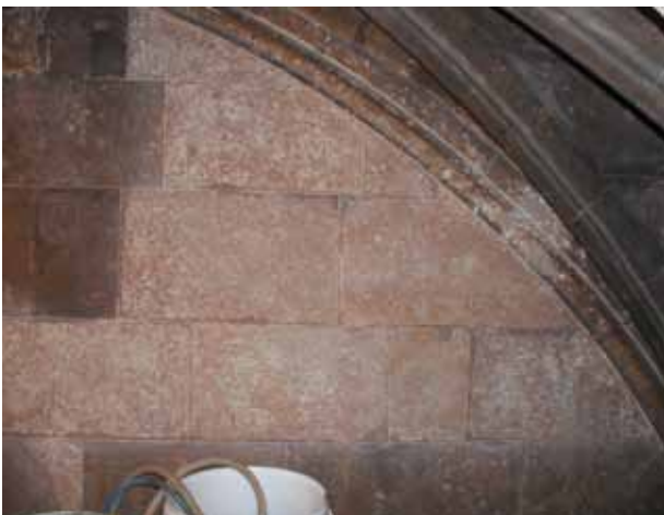
Fig. 19,20 i 21. Proves de neteja mitjançant projecció d'àrid a pressió controlada. Portal lateral esquerre. Fig. 19,20 y 21. Pruebas de limpieza mediante proyección de árido a presión controlada. Portal lateral izquierdo
