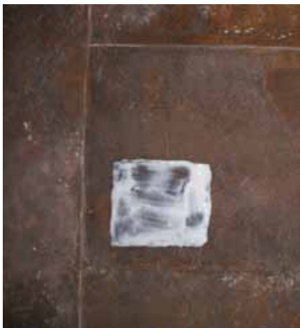
Fig. 16,17 i 18. Proves de neteja amb diferents sistemes. Portal lateral esquerre. Fig. 16,17 y 18. Pruebas de limpieza con diferentes sistemas. Portal lateral izquierdo
