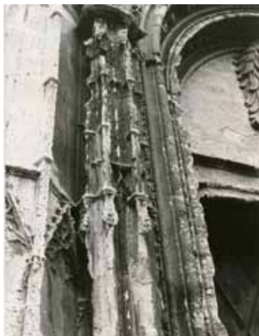
Fig. 1. AGCM, fotografia de l'any 1970, F-10. És perceptible el despeniment del vernís. Fig. 2. IAAH, façana nord, porta, C-8682, any 1913. Es veu l'entrada per la façana nord tapiada i acabada amb sèrum. Fig. 1. AGCM, Fotografía de los años 1970, F-10. Es perceptible el desprendimiento del barniz. Fig. 2. AAH, Fachada Norte, Porta, C-8682, Año 1913. Se ve la entrada por la fachada norte tapiada y acabada con sérum
