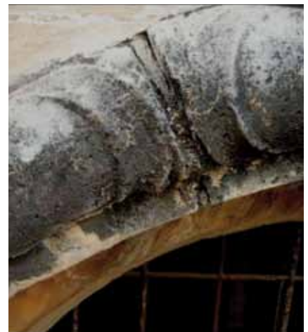
Fig. 5. Vista general abans del procés. Fig. 6 i 7. Detalls de microorganismes. Fig. 5. Vista general antes del proceso. Fig. 6 y 7 Detalles de microorganismos
