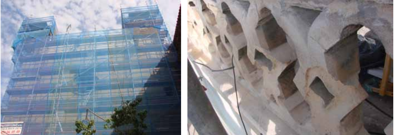
Fig. 1, 2, 3, 4. Façana i detalls de l'església de Santa Teresa de Jesús de Palma durant les obres de restauració el 2009 Fig. 5. Portalada de l'església dels mínims a Campos. Fig. 1, 2, 3, 4. Fachada y detalles de la iglesia de Santa Teresa de Jesús de Palma durante las obras de restauración el 2009 Fig. 5. Portalada de la Iglesia de los Mínimos en Campos
