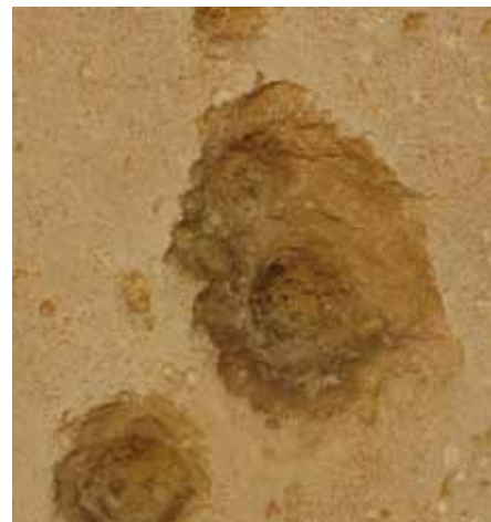
Fig. 13. Pàtina biològica de la pedra exposada a l'exterior. Fig. 14. Metall incrustat a la pedra. Fig. 15. Impactes de bala. Fig. 13. Pátina biológica de la piedra expuesta en exterior. Fig. 14. Metal incrustado en piedra. Fig. 15. Impactos de bala
