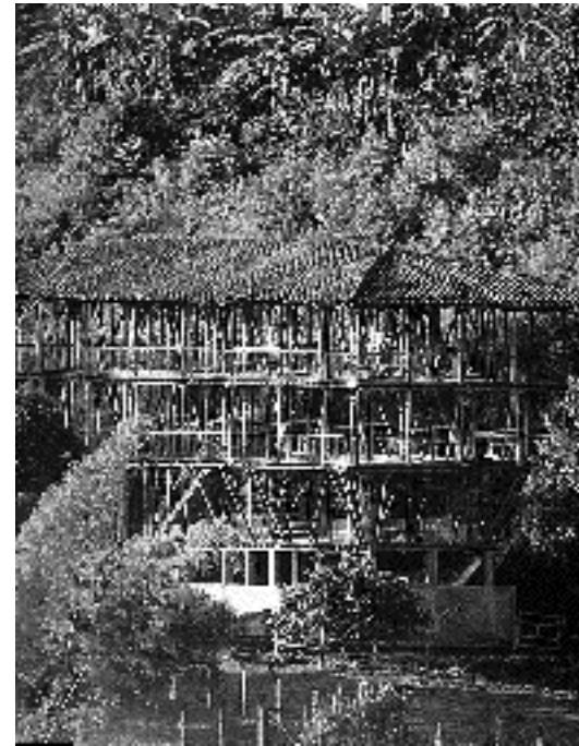
Oreador o secadero para café construido con guadua y esterilla. Santa Rosa de Cabal, Risaralda (Colombia). Foto: Jorge Eduardo Arango (del libro de Marcelo Villegas, Bambusa Guadua , Villegas Editores, 1989).
