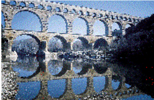
Pont du Gard, Remoulins (Francia). Foto: A. González, 24.02.1990.
