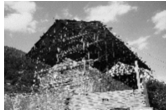
Cercado y protección de la iglesia de Sant Vicenç de Rus, Castellar de N'Hug (Berguedà, Barcelona), y su entorno, previos al inicio de los trabajos de investigación arqueológica. Foto: A. González, 05.07.1985.
