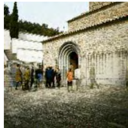
Nueva portada de acceso a la iglesia de Sant Vicenç (siglos X al XX), Malla (Osona, Barcelona), construida en hormigón armado siguiendo las trazas, dimensiones y vibración formal de la portada románica (siglo XII) —que había sido desmontada y trasladada al museo diocesano de Vic hacia 1900—, en el curso de la restauración y reconstrucción tipológica del edificio (arquitecto A. González, 1982-1986). Foto: M. Baldomà, 12.10.1997.
