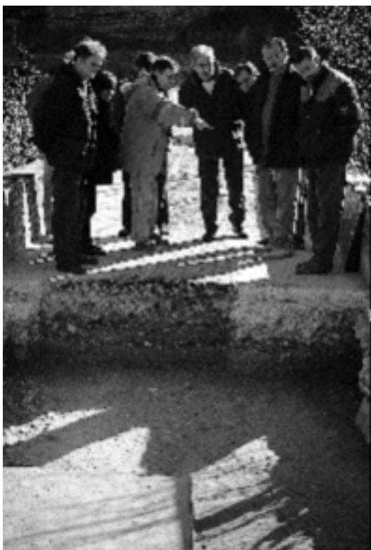
Arquitectos e historiadores en una visita conjunta a los trabajos de restauración del puente de Periques, Puig-reig (Berguedà, Barcelona). Foto: M. Baldomà, 16.06.1994.
