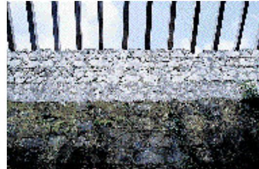
Utilización de coral en la restauración de un edificio en Portobelo (República de Panamá). Foto: A. González, 20.11.1994.
