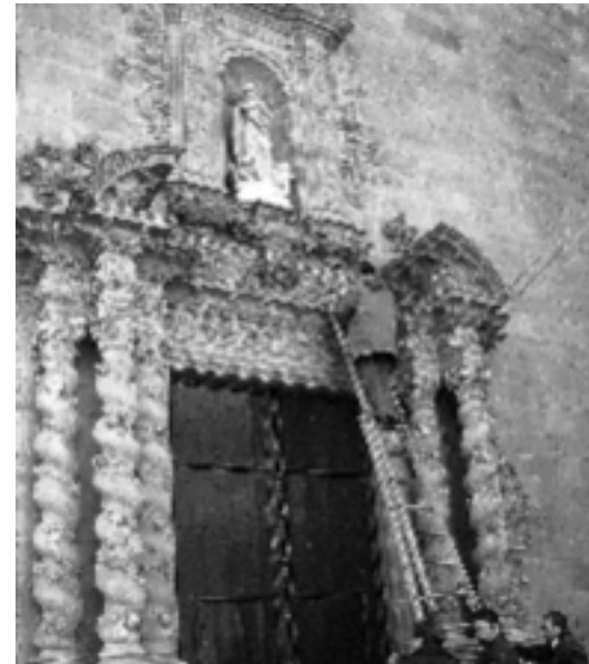
Visita de verificación del estado de conservación de una obra restaurada. Portada barroca (1697-1701) de la iglesia parroquial, Caldes de Montbui (Vallès Occidental, Barcelona), restaurada por el SPAL (1983-1984). Foto: M. Baldomà, 08.02.1994.
