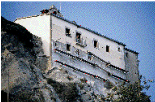
Andamiaje para la restauración de la fachada de mediodía del santuario de Bellmunt (siglos XVI al XVIII), Sant Pere de Torelló (Osona, Barcelona), aprovechando los mechinales de la construcción original, que de nuevo quedaron destapados (arquitectos, A. González, J. Rovira Pey, 1981-1990). Foto: A. González, 28.10.1986.
