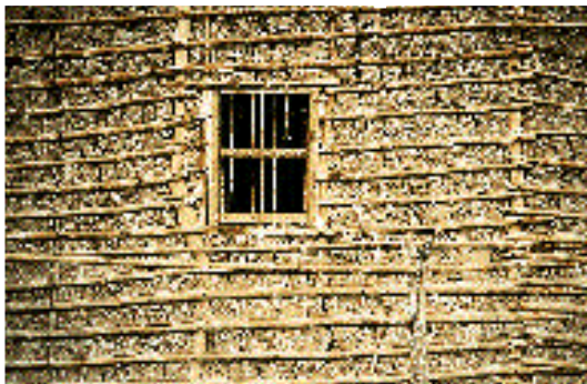
Casa construida con bahareque (tierra y guadua), Caldas (Colombia). Foto: José Fernando Machado (del libro de Marcelo Villegas, Bambusa Guadua , Villegas Editores, 1989).
