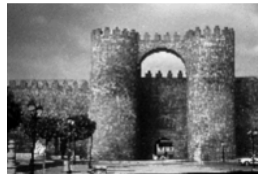
La puerta de San Vicente (siglo XI, restaurada en el XVI) de la muralla de la ciudad (restauradas por Anselmo Arenillas en la década de 1960, por encargo del Ministerio de Educación), Ávila. Foto: A. González, 30.09.89.
