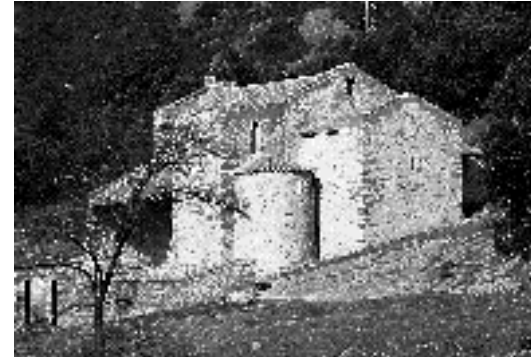
La iglesia de Sant Quirze de Pedret (siglos IX al XIII), Cercs (Berguedà, Barcelona), después de la segunda campaña de restauración, entre 1989 y 1995. Foto: M. Baldomà, 06.02.1998.
