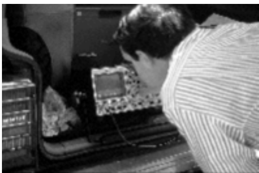
Ensayo in situ para contrastar los modos de vibración previstos en un modelo informático del puente gótico de Periques, Puig-reig (Berguedà, Barcelona), realizado por P. Roca y C. Molins (UPC) por encargo del SPAL. Fotos: M. Baldomà, 16.06.1994.
