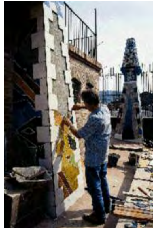
El maestro albañil Angel Coll, revisitando la chimenea número 7 de la azotea del Palacio Güell de Barcelona, de acuerdo con el diseño del arquitecto y pintor Domingo García-Pozuelo Asins. Foto: M. Baldomà, 03.06.1992.
