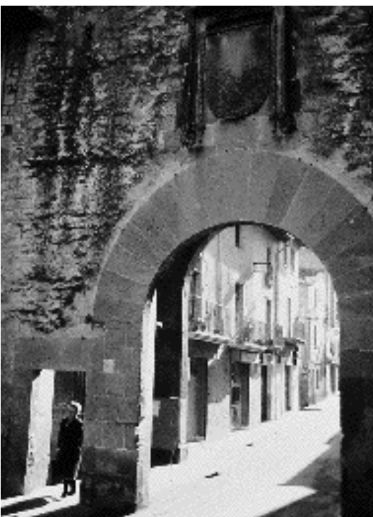
Puerta de la antigua muralla del siglo XVI, Centelles (Osona, Barcelona), restaurada por Jeroni Martorell en 1919. Foto: A. González, 05.02.1987.
