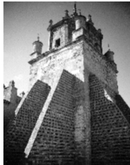
Torre en el recinto del monasterio cisterciense de Veruela (arquitecto restaurador, José María Valero), Vera de Moncayo (Zaragoza). Foto: A. González, 11.06.1986.
