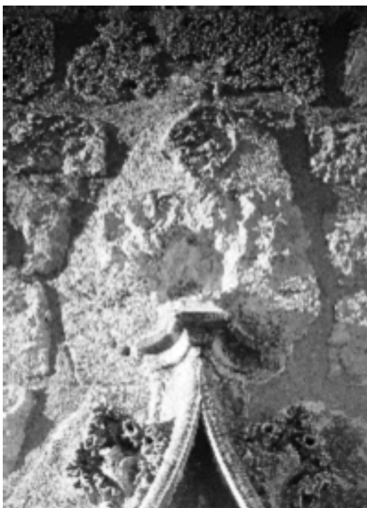
Trazas del desaparecido florón de coronación del gablete de la portada gótica (siglo xv) de la iglesia de Santa Cándia, Orpí (Anoia, Barcelona), que sirvieron para su recuperación. Foto: A. González, 24.01.1984.
