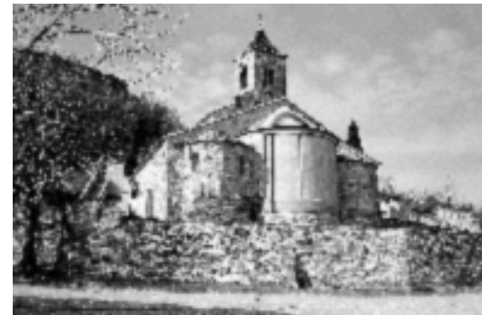
Cabecera de la iglesia parroquial de Sant Vicenç (origen, siglo X, fábrica actual, siglos XI y XII), Malla (Osona, Barcelona), después de la restauración y la recuperación tipológica (arquitecto, A. González, 1982-1986). Foto: M. Baldomà, 02.1997.
