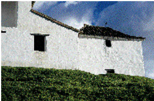
Muros revestidos. Capilla de Siecha, Guasca (Cundinamarca, Colombia). Foto: A. González, 02.08.1998.
