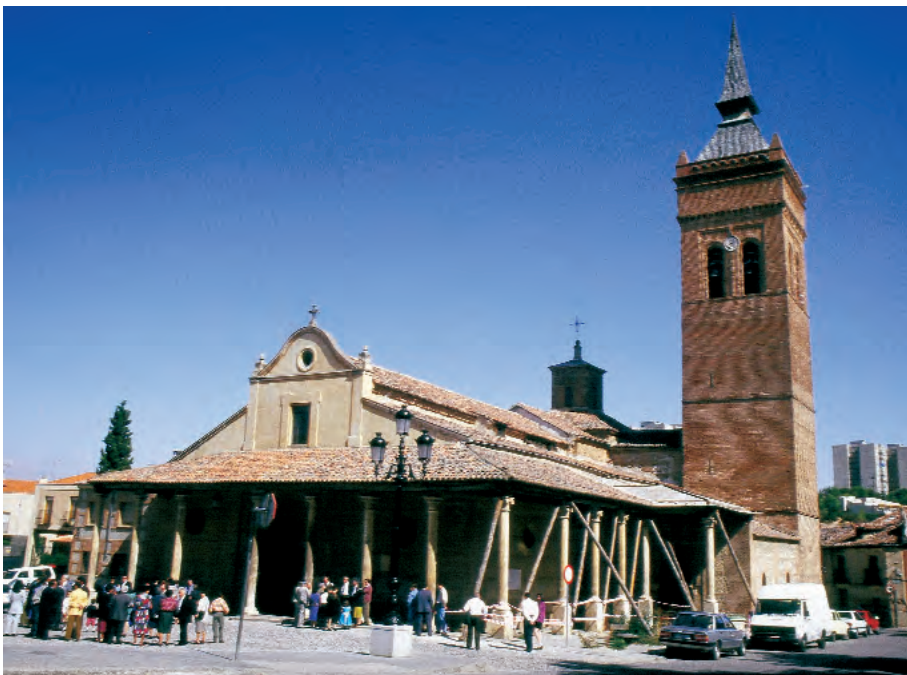
Estado general de la iglesia de Santa María de la Fuente, Concatedral de Guadalajara, previo a la intervención. Foto: José Juste Ballesta
