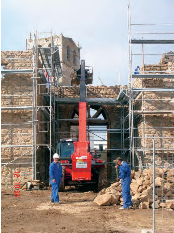
Estado de las obras de reconstrucción de la puerta medieval en abril de 2006. Foto: María Antonia Pardo Fernández
