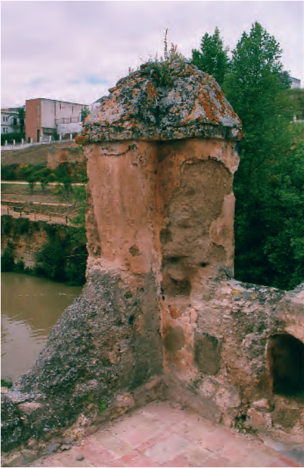
Molino del Algarrobo: restauración del merlonado. Foto: Enrique Luis Domínguez Berenjano y Lara Cervera Pozo
