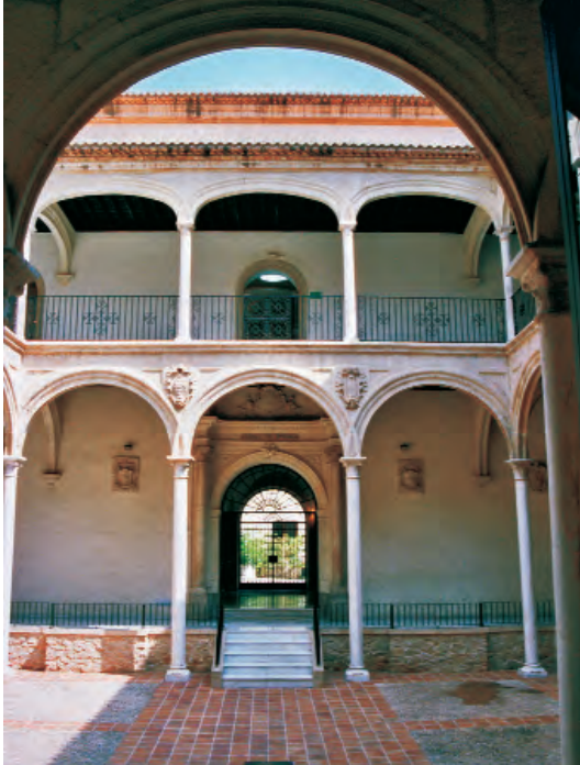
Restauración de 1985. Foto: Félix Santiuste de Pablos
