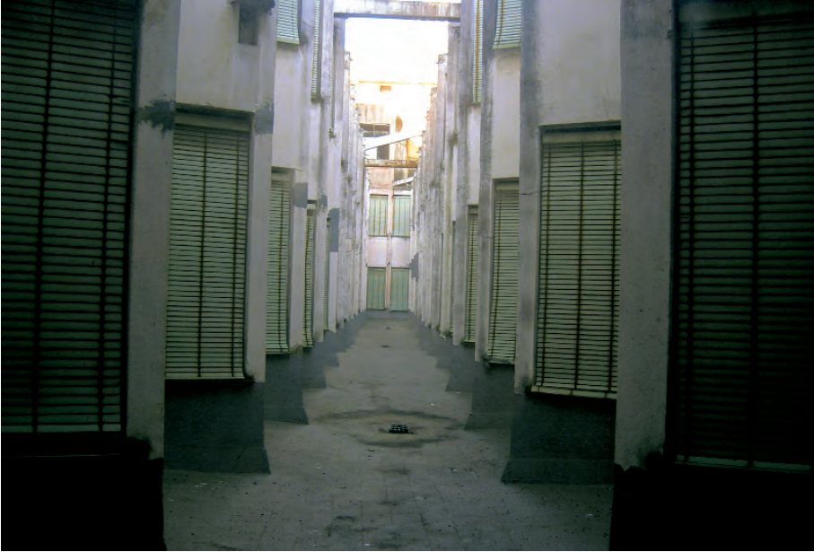
Vista de uno de los patios de las camarillas ejecutadas por José Galnares, 2003. Foto: Eduardo Mosquera Adell
