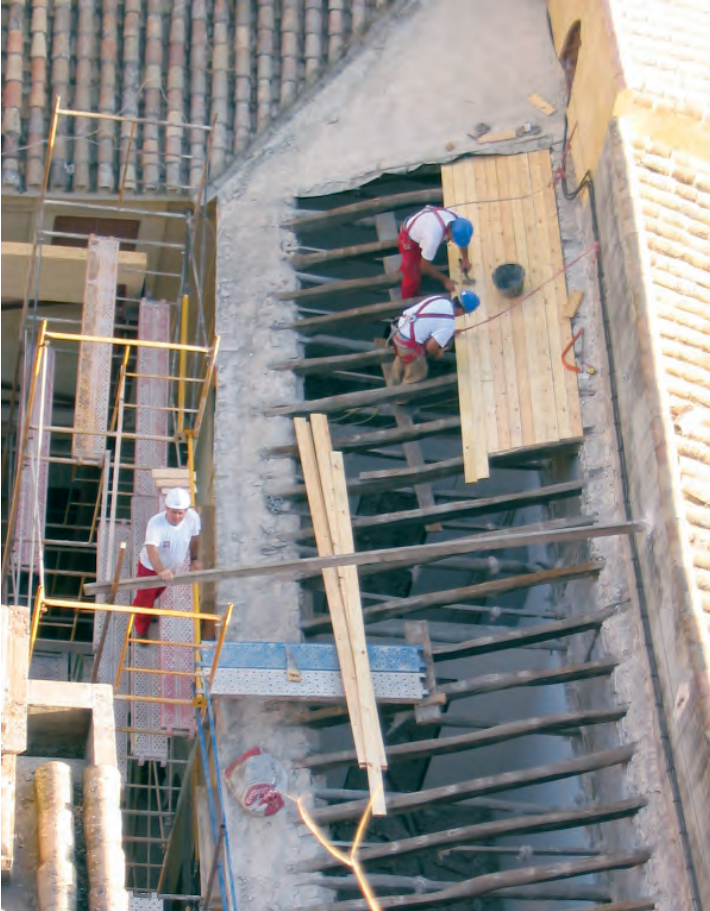
Obra en cubiertas, 31 de agosto de 2004. Foto: Estudio Fernando Mendoza Castells
