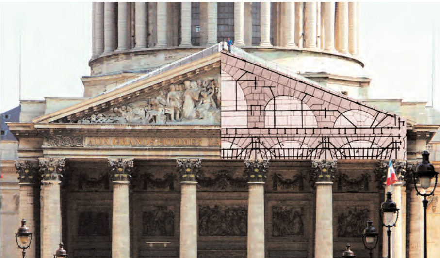
El pronaos de la Iglesia de Santa Genoveva de París es uno de los primeros ejemplos de sillería armada al servicio de unas formas arquitectónicas fuera de escala. Foto: José Luis González Moreno-Navarro con un detalle extraído de RONDELET, Jean. L'art de bâtir . Paris, 1802-1818
