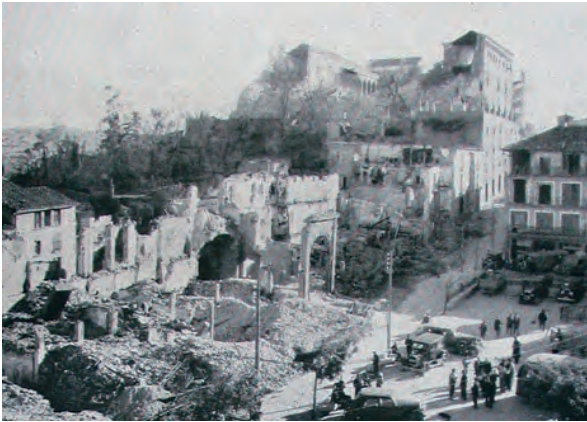
Plaza de Zocodover. Emplazamiento del Gobierno Civil, antes de comenzar las obras. Fuente: Publicada en Reconstrucción núm. 33, 1943, mayo, p. 163
