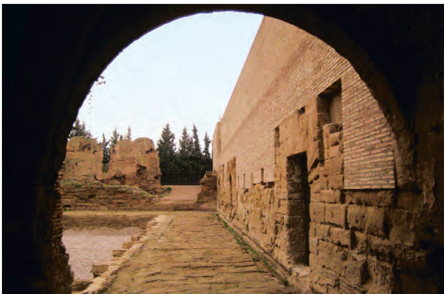
Vista del lienzo norte del claustro después de la última restauración. Foto: Luis Franco y Mariano Pemán, 2006
