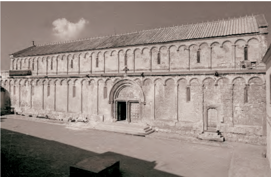
San Gavino en Porto Torres después de la restauración de Vico Mossa, posterior a la Segunda Guerra Mundial, después de la sustitución de la escalinata semicircular dejada por Dionigi Scano con tres escalones rectangulares. Fuente: Archivo de la Superintendencia de Bienes Arquitectónicos y del Paisaje de las Provincias de Sassari y Nuoro
