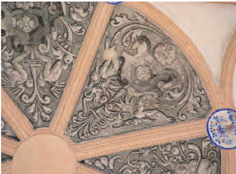
Parroquia de San Cristóbal de Heredia, Álava. Detalle de la rueda central de una bóveda. Foto: Mercedes Cortázar García de Salazar, Dolores Sanz Gómez de Segura, Diana Pardo San Gil
