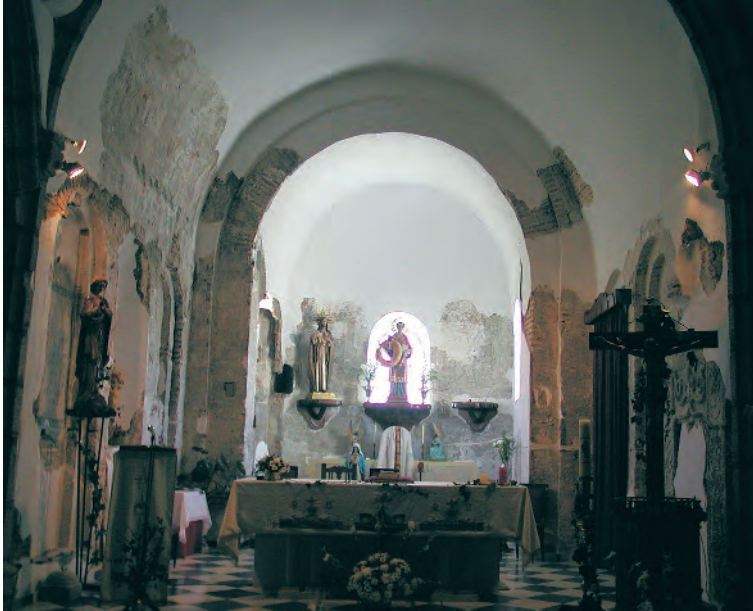
Vista general del interior de la cabecera de la iglesia. Se aprecian los restos de pinturas y el muro de ladrillo descubiertos, y la iluminación natural excesiva. Igualmente la bóveda del tramo presbiterial y la falsa bóveda de medio cañón que enmascara gran parte del cascarón original. Esto ha venido confundiendo sobre el sistema constructivo del ábside, ya que suponía una extraña disposición arquitectónica en esta tipología. Foto: Antonia Garrido Martínez
