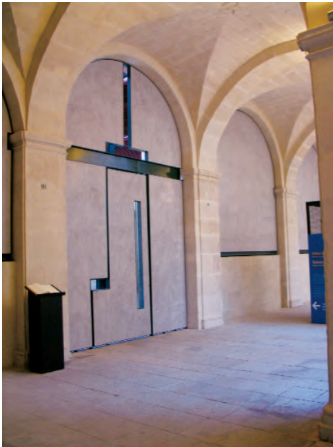
Cerramiento interior de la fachada norte del claustro. Foto: Santiago Varela Botella
