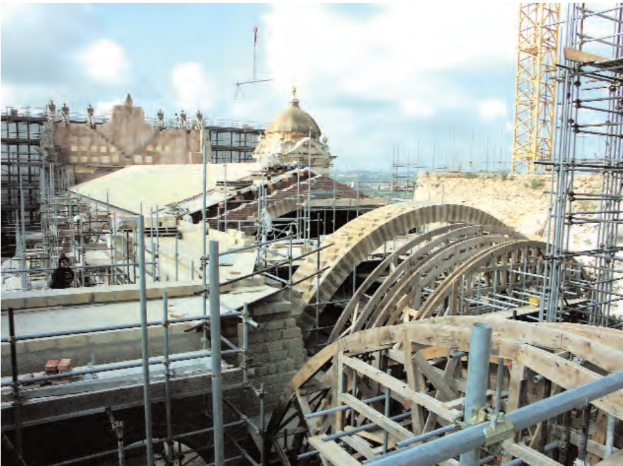
En la reconstrucción de la Catedral de Noto se recuperó en sillería (sin armar, obviamente) todo el conjunto de pilares y arcos que dan soporte a la recuperada cubierta a dos aguas y a la bóveda de cañón seguido encamionada del interior. Foto: José Luis González Moreno-Navarro
