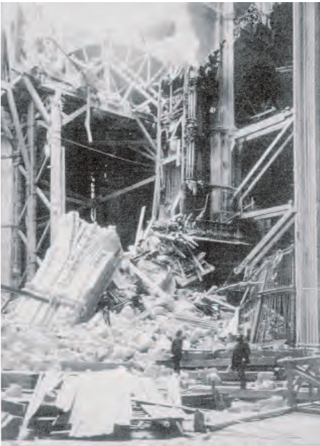
Colapso dramático pero local debido al fallo de pilar del ángulo sur-oeste del crucero de la Catedral de Sevilla en 1888. Fuente: El espíritu de las antiguas fábricas . Sevilla: FIDAS, 1999
