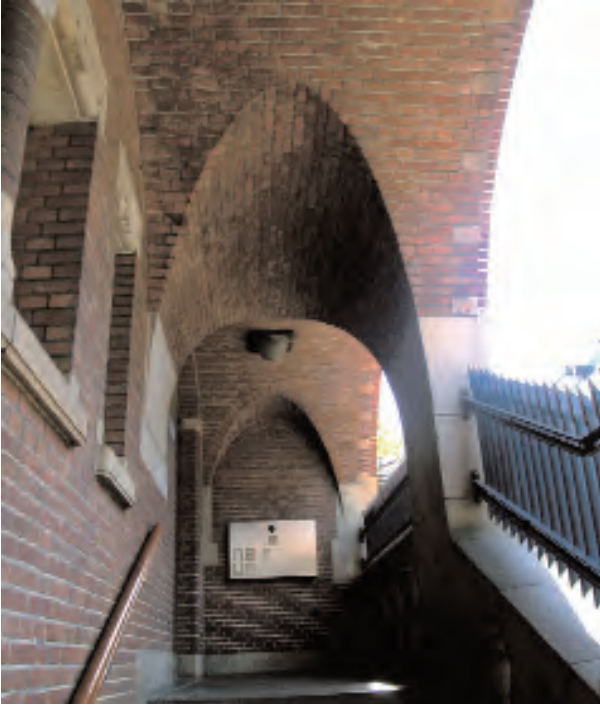
Pequeña bóveda parabólica en las escaleras de acceso a la Bolsa de Ámsterdam de H. P. Berlage, 1903 Foto: Pablo Latorre González-Moro
