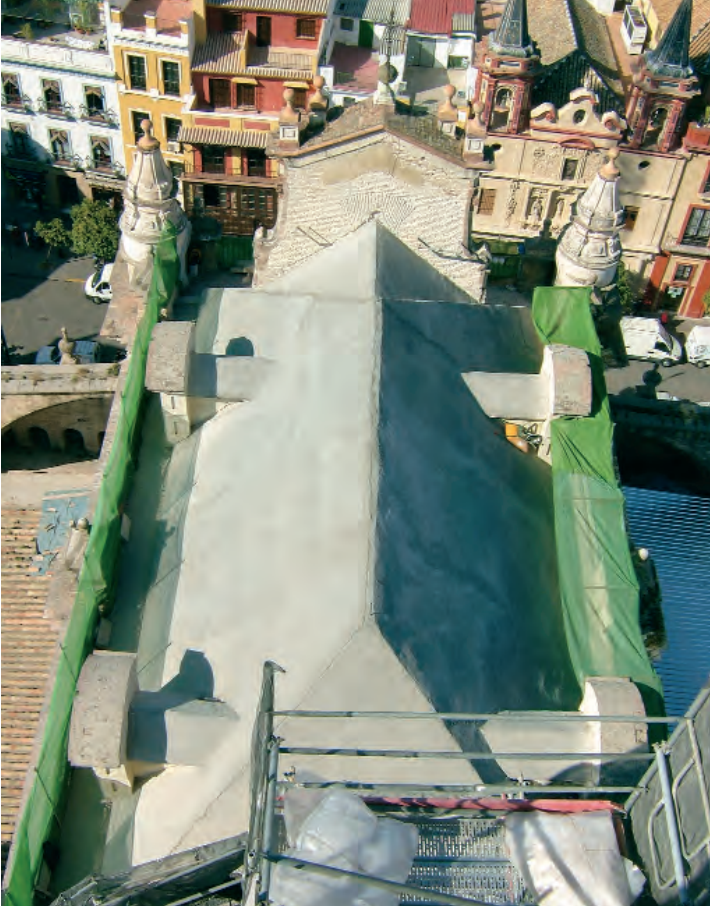
Obra en cubiertas. Foto: Estudio Fernando Mendoza Castells
