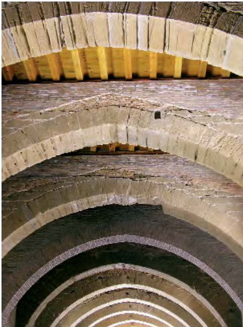
Completamiento y cubrimiento de los arcos, 2006. Foto: Luis Franco y Mariano Pemán
