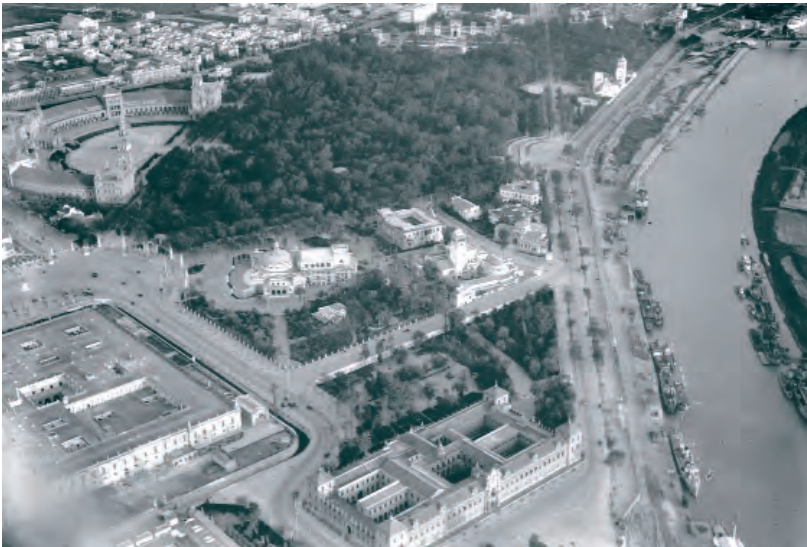
Vista de 1929 tomada desde el Zeppelin, mostrando las obras de Basterra, culminadas el año previo. Fuente: © Fototeca Municipal de Sevilla (ICAS-Servicio de Archivo, Hemeroteca y Publicaciones), archivo Sánchez del Pando
