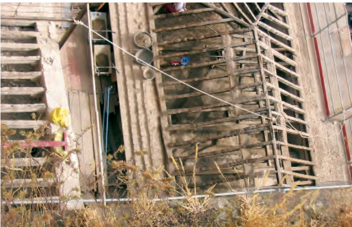
Obra en cubiertas, 23 de julio de 2004. Foto: Estudio Fernando Mendoza Castells
