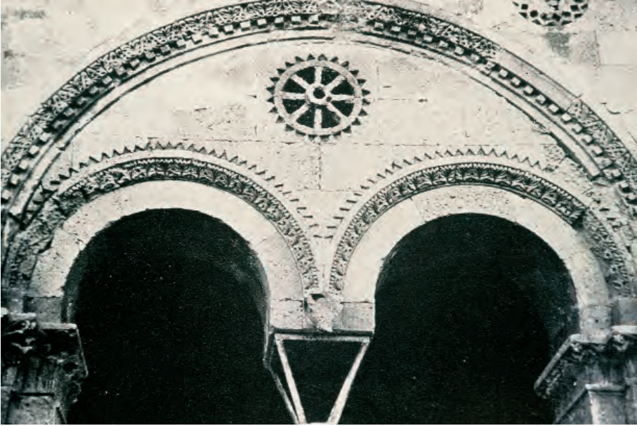
Sant'Antioco de Bisarcio. Restauración de bifora en la fachada. Fuente: SAMPAOLESI, P. Discorso sulla metodologia generale del restauro dei monumenti . Edam: Firenze, 1980, lámina 221
