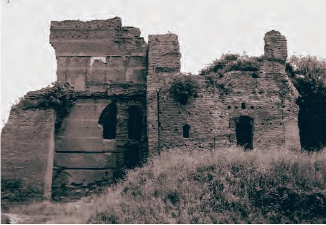
Imagen lateral del edificio llamado Pretorio en Villa Adriana con los contrafuertes decimonónicos que eliminaron la imagen de los grabados de Piranesi. Fuente: Fondo fotográfico de la Soprintendenza Archeologica del Lazio (Roma)
