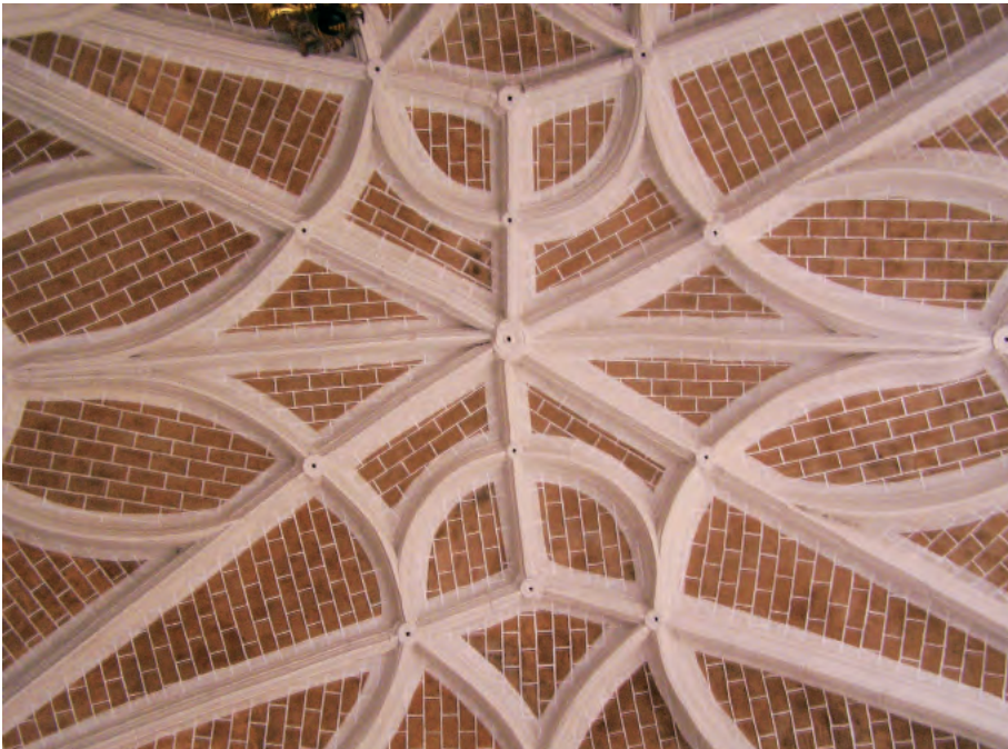
Bóveda de la Capilla del Rosario antes y después de la restauración. Foto: Joaquín Naval Mas
