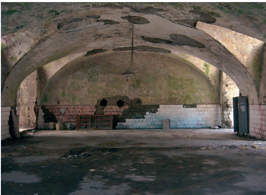
Vue partielle d'un espace voûté sous une des nefs de l'église inachevée, espace proposé pour un centre de communication sur le patrimoine mondial Foto: Nicolas Detry, 2005
