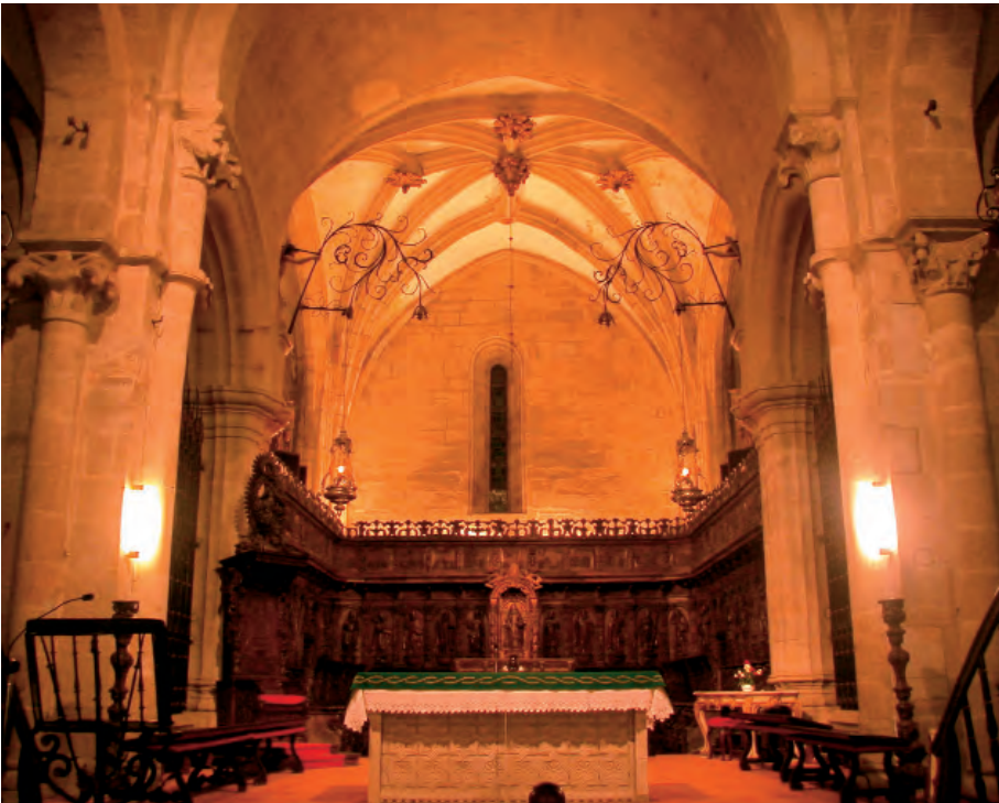
Vista del presbiterio después de la ejecución del proyecto de iluminación. Fuente: Archivo del Plan Director
