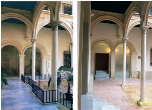
Restauración arco geminado. Fotos: Izquierda. Arcadas recuperadas en el claustro. Rehabilitación del Colegio de San Esteban para sede del Gobierno Regional de Murcia. Dragados y Construcciones, S.A. 1985. Derecha. Restauración arco geminado. Foto: Félix Santiuste de Pablos
