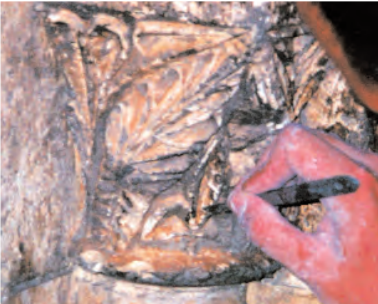
Mecánica bisturi: Limpieza mecánica simple mediante bisturi de depósitos de suciedad. Foto: Manuel Iglesias Campos, Virtudes Azorín López, María Isabel Sánchez de Rojas, Moisés Frías Rojas
