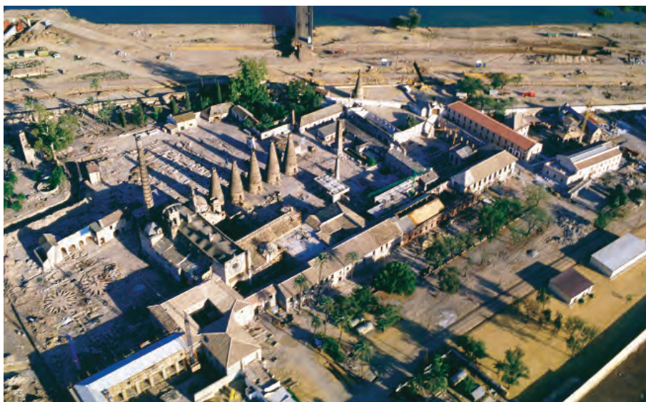
Foto aérea de la fábrica del Monasterio de la Cartuja en obras, en 1987. Centro Andaluz de Arte Contemporáneo
