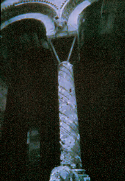
Sant'Antioco di Bisarcio después de la apertura de las arcadas, con la reposición de un capitel del pórtico con alambre, diseñado por el superintendente Renato Salinas en 1958. Fuente: Archivo de la Superintendencia de Bienes Arquitectónicos y del Paisaje de las Provincias de Sassari y Nuoro
