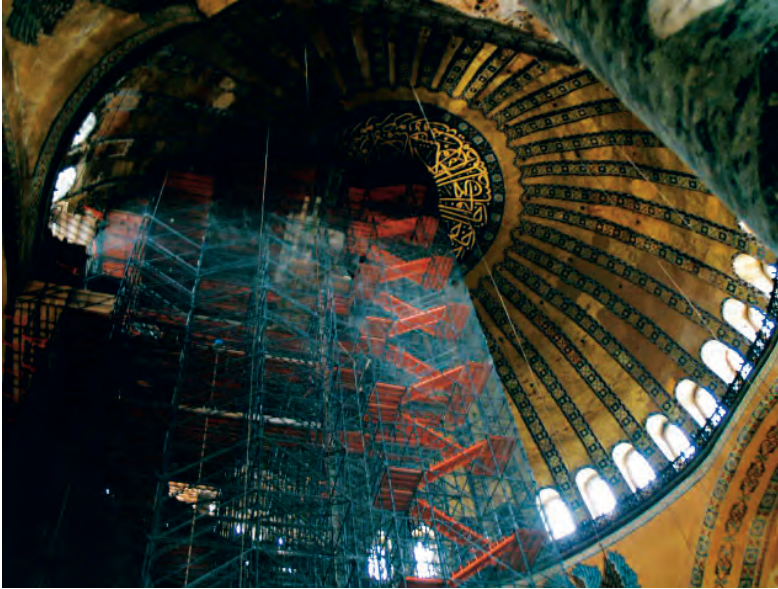
Interior de Santa Sofía, en restauración. Foto: Pablo Herrero Lombardía
