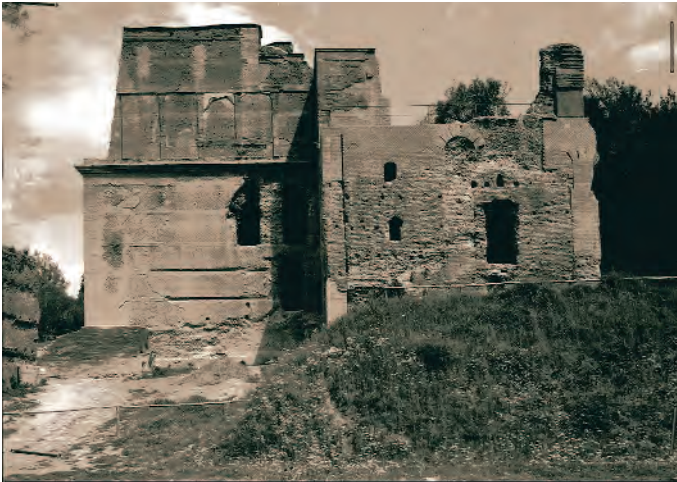
Imagen lateral del edificio llamado del Pretorio tras los trabajos de eliminación de los contrafuertes, llevados a cabo en la segunda mitad del siglo XX. Fuente: Fondo fotográfico de la Soprintendenza Archeologica del Lazio (Roma)
