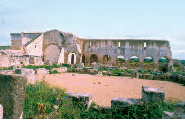
Santa Maria di Paulis, hoy, respetando algunas restauraciones "historicistas" de Piero Cao, evidenciadas con coloraciones diversas. Foto: Stefano Gizzi
