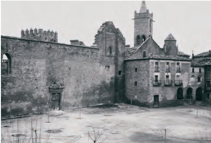
Los edificios situados junto al palacio viejo que, al construir el Parador, se van a derribar, 1963. Fuente: Archivo Institución Príncipe de Viana (IPV)
