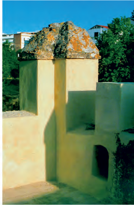
Molino del Algarrobo: restauración del merlonado. Foto: Enrique Luis Domínguez Berenjano y Lara Cervera Pozo
