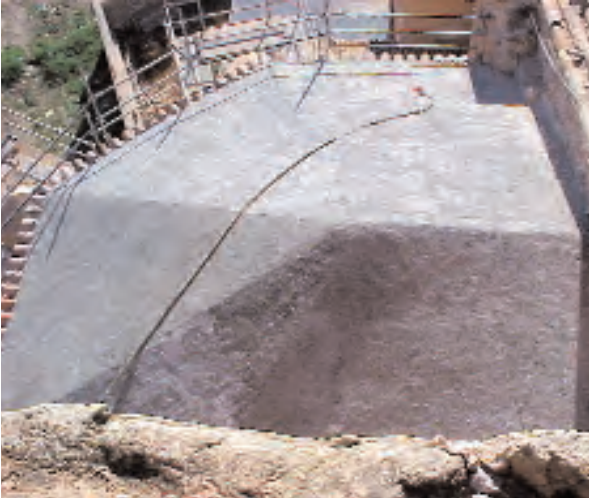
Cubierta de la semicúpula antes de colocar la teja. Foto: Miguel Louis Cereceda
