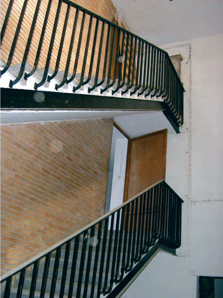
Escalera introducida por Galnares para acceso a las nuevas camarillas ejecutadas por José Galnares, 2003. Foto: Eduardo Mosquera Adell
