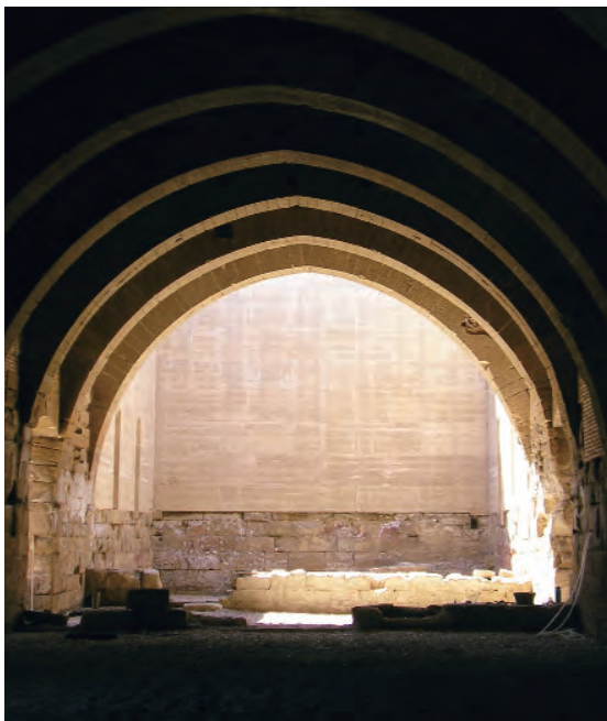
Nave norte de dormitorios después de la última restauración. Foto: Luis Franco y Mariano Pemán, 2006
