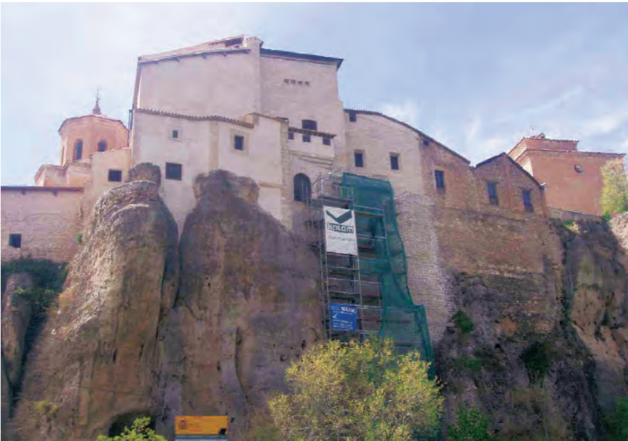
Fachada de la Catedral de Cuenca que mira al río Huécar después del proceso de restauración. Fuente: Proyecto de restauración y rehabilitación de la Catedral de Cuenca
