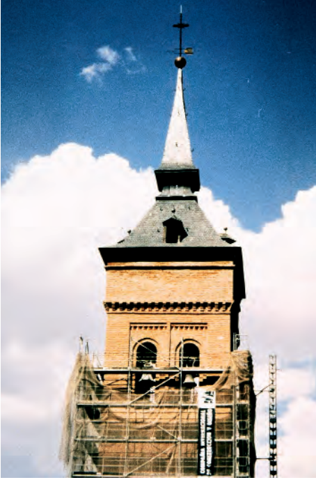
Chapitel de la torre, después de la "des-restauración". Foto: José Juste Ballesta
