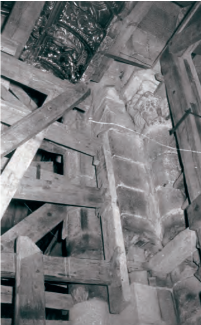
Reconstrucción de pilar, 10 de febrero de 1957. Fuente: Archivo Vila
