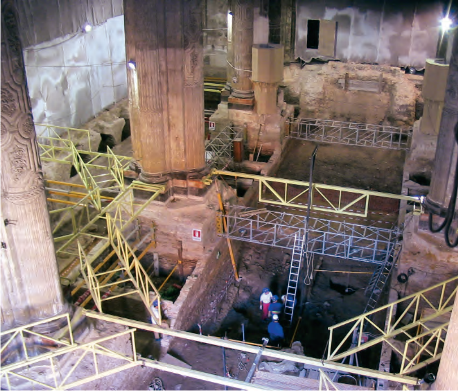
Pasarelas durante la obra. Foto: Estudio Fernando Mendoza Castells
