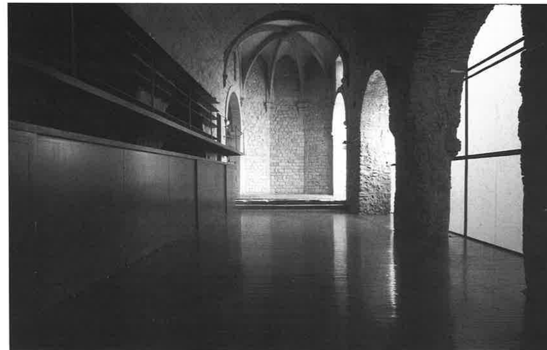
Interior de la nau amb el moble de doble funció (vitrines museístiques i biblioteca). Fotos: M. Baldomà. SPAL, 2.6.1992 / 18.2.1993.
