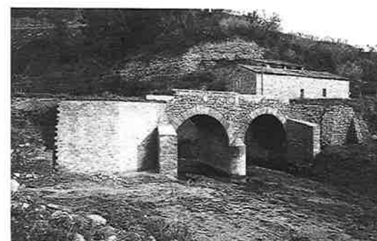
La mateixa vista durant el procés de les obres. Foto: Joan Francés, SPAL, 9.3.1987.
