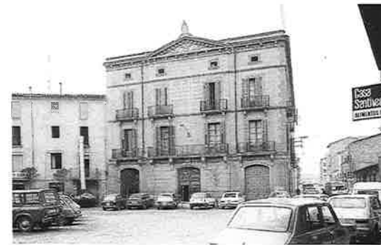
Façana principal de Can Puget, a la plaça Dalt Vila, abans de la restauració. Foto: Joan Francés, SPAL, 25.2.1985.
