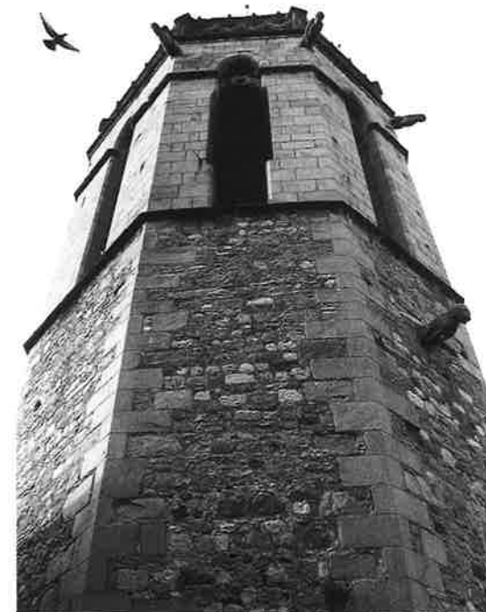
Vistes del campanar després de la intervenció. Fotos: M. Baldomà. SPAL, 1.3.1995.
