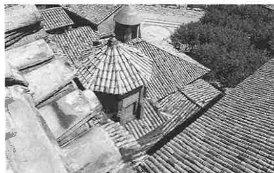
Cobertes de les capelles de migdia abans de les obres. Foto: Joan Francés. SPAL, 13.5.1985. A la dreta, portada de la plaça del Mercat. Foto: Antoni González. SPAL, març 1988.
