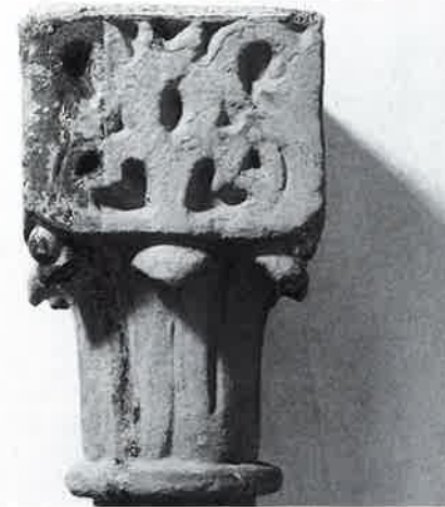
Proves de decapatge de les pintures d'un capitell de la façana per trobar-ne la policromia original. Foto: Joan Francés. SPAL, gener 1990.
