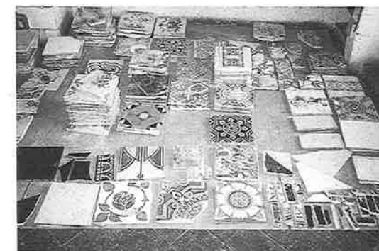
Rajoles de ceràmica vidriada adquirides en botigues d'antiquaris per restaurar les xemeneies del terrat. Foto: R. Lacuesta. SPAL, 14.2.1992.
