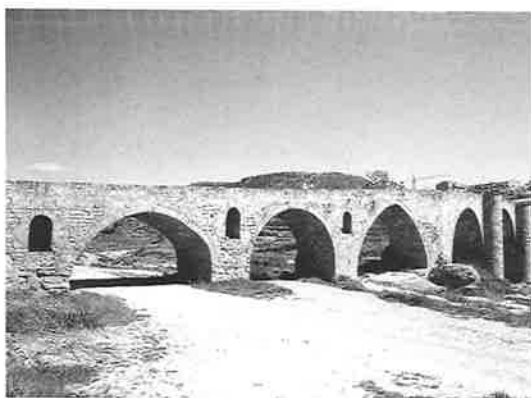
Vista general del pont des d'aigües avall, abans de la restauració. A la dreta, aspecte d'un dels tallamars orientals. A la roca hi ha forats de pal, potser de la palanca de començament del segle XVIII. Fotos: Joan Francés, SPAL, 13.4.1987.
