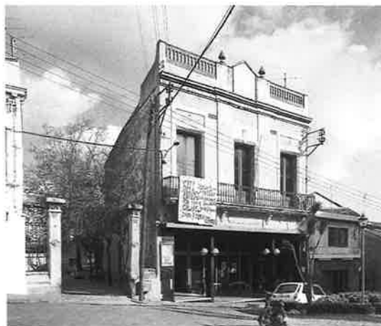
Façana principal del teatre del Centre Vilassanès. Foto: Joan Francés. SPAL, 3.2.1983.
