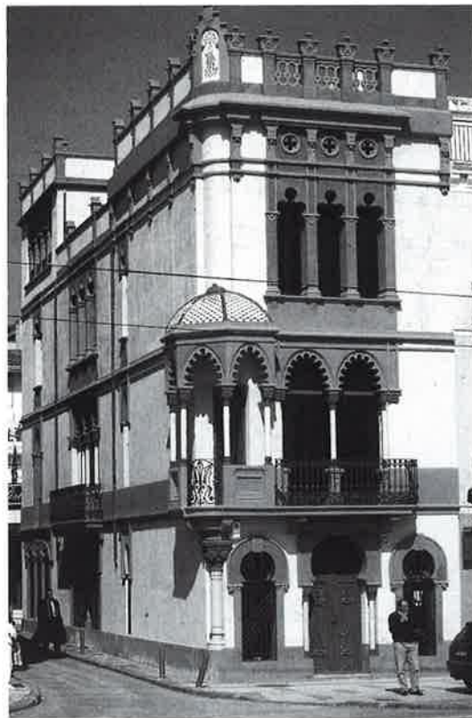
Dos aspectes de les façanes de la nova Casa de Cultura del Masnou, després de la restauració. Fotos: M. Baldomà. SPAL, 5.4.1993/16.3.1993.
