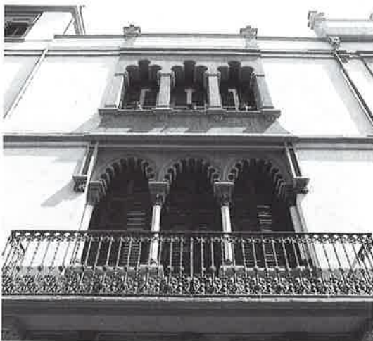
Detalls del coronament, la tribuna i els balcons i finestres de la façana principal després de la restauració. Fotos: M. Baldomà. SPAL, març/abril 1993.
