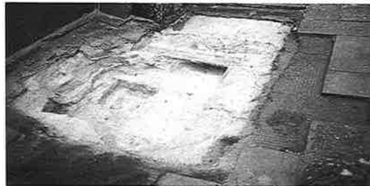
Detall d'una cala arqueològica efectuada al terrat per estudiar-ne el sistema constructiu. Foto: J.M. Moreno, SPAL, 19.10.1988.
