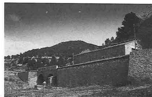
Vista general del pont i dels murs de contenció de la carretera, un cop restaurats. Foto: Jordi Isern, SPAL, 8.3.1993.
