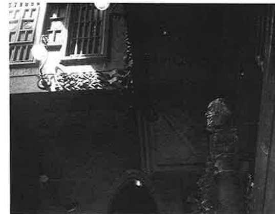
A l'esquerra, interior de la lluneta amb els arcs parabòlics en degradació. Foto: Jordi Isern, SPAL, 3.4.1991. A la dreta, l'únic dia d'aquest segle que la llum solar va banyar les façanes interiors de la sala. Foto: arxiu GMN, 3.4.1991.
