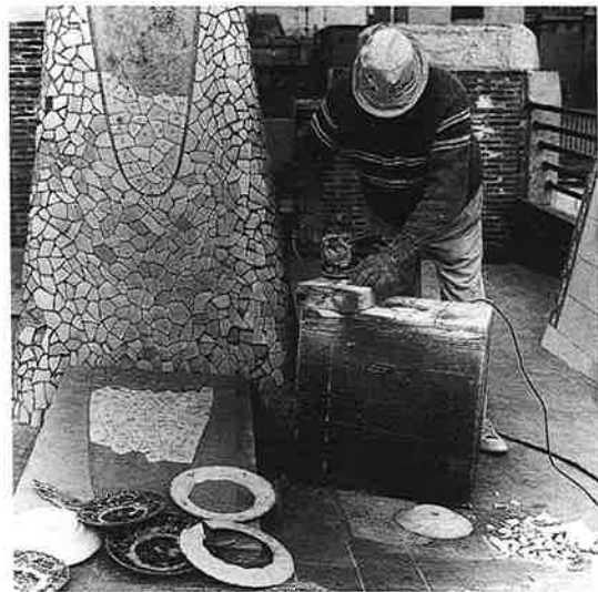
Procés de restauració de la xemeneia núm. 9, revestida de pisa blanca. Foto: M. Baldomà. SPAL, 24.2.1992. Les xemeneies d'obra vista després de la restauració. Foto: M. Baldomà. SPAL, 19.7.1994.
