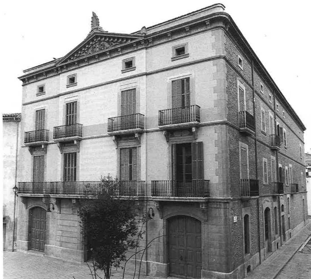
Façanes a la plaça Dalt Vila i al carrer Alta Cortada, després de les obres de restauració. Foto: M. Baldomà, SPAL, 4.2.1993.
