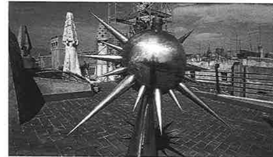
A l'esquerra, l'arquitecte tècnic Josep M. Moreno, en un moment del muntatge del penell-parallamps, un cop restaurat. A la dreta, l'esfera-estrella dels vents després de la restauració. Foto: Jaume Soler, SPAL, 15.3.1989.
