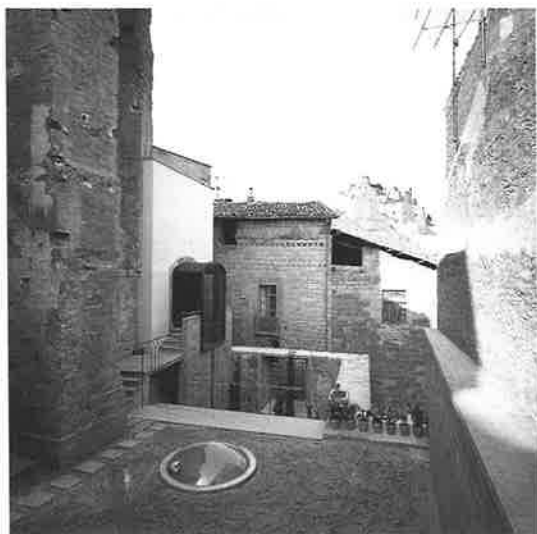
Recinte enjardinat, resultat del desmuntatge de la sagristia vella, i nou accés al cambril de la Mare de Déu del Patrocini. Foto: Jaume Soler, SPAL, 8.5.1990.
