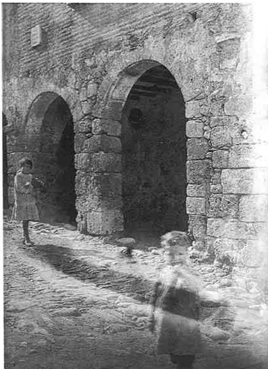
L'antiga Casa de la Vila, abans de 1917, data en què es van tapiar en part els arcs del porxo. Foto: Carrera, SPAL. A la dreta, aspecte que oferiria l'immoble abans de les obres de restauració, amb part del porxo tapiat. Foto: Joan Francés, SPAL, 3.2.1990.
