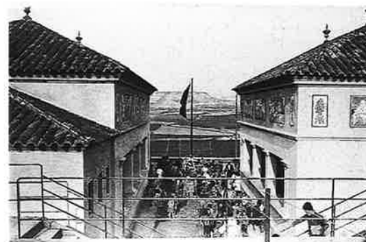
A dalt, construcció de l'estructura de coberta de l'edifici. A continuació, tres vistes de les escoles poc després de la seva inauguració. Fotos: Manuel Gausa, 1927/1929. Col·lecció particular.
