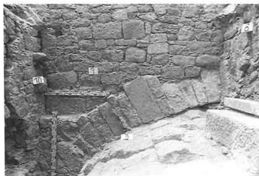
Detall de la fonamentació de l'antiga sagristia en el moment de ser documentada durant l'excavació arqueològica. Foto: Ramon Espadaler, SPAL, 15.9.1987.
