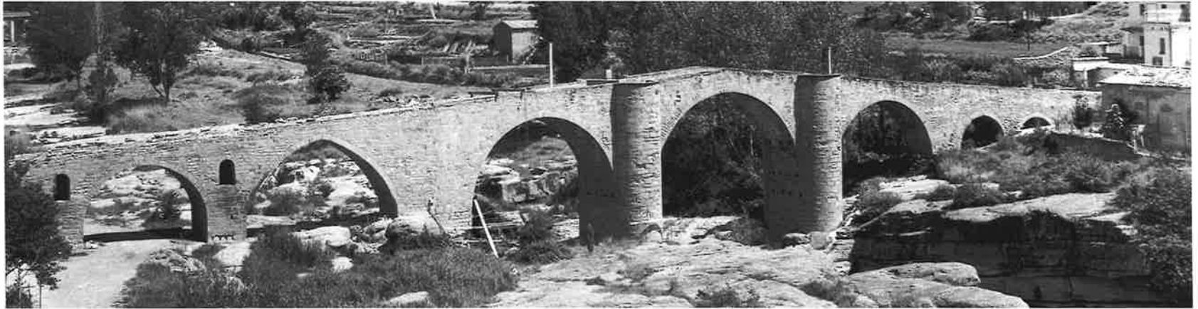
El pont durant les obres de restauració, vist des d'aigües avall. Foto: Joan Francés, SPAL, 16.5.1990.
