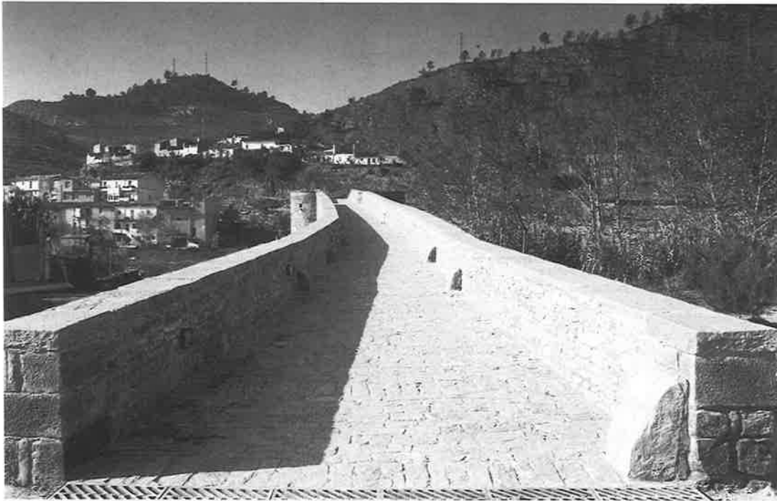
Accés al pont des del costat de Vilomara, amb el nou paviment inspirat en el del segle XVII. Foto: Jordi Isern, SPAL, 11.11.1991.
