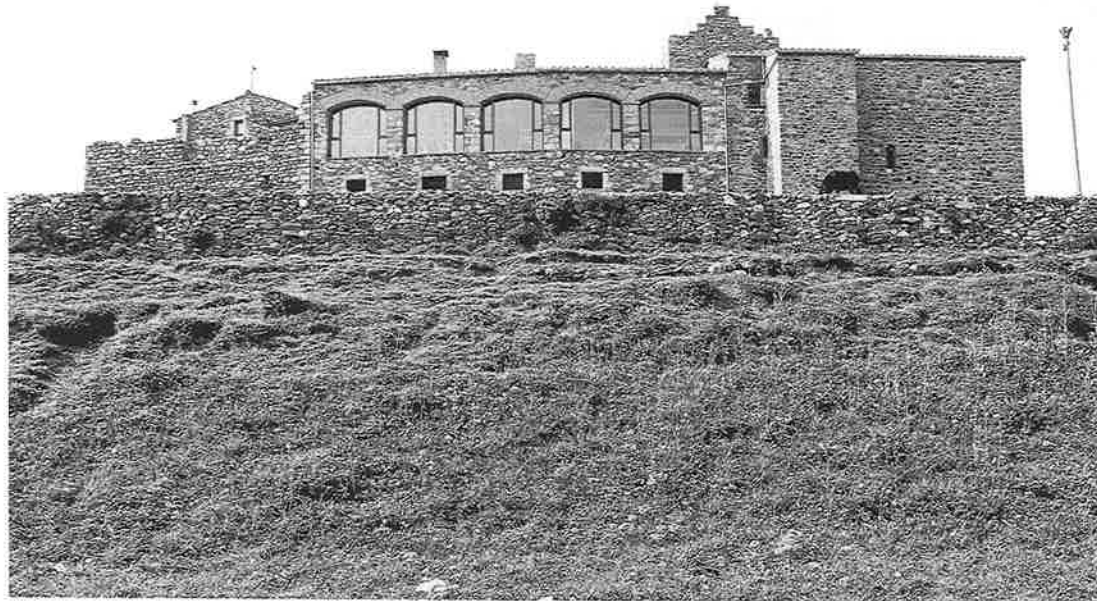
Façana meridional de l'hostatgeria després de la darrera intervenció. Foto: Jordi Isern. SPAL, 15.5.1991.
