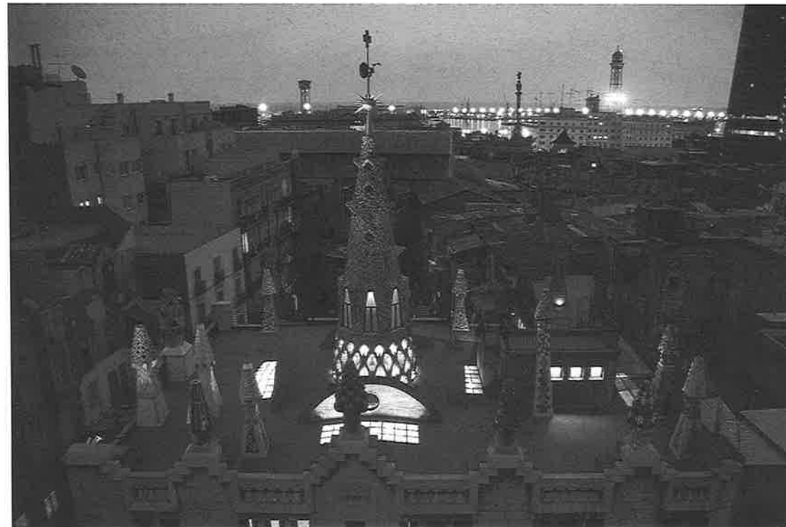
Vistes nocturnes del terrat, després de la intervenció. Fotos: M. Baldomà, SPAL, 13.1.1994/19.7.1994.
