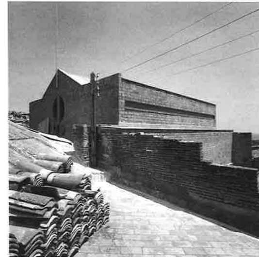
Façana de l'escenari, durant les obres de restauració. Foto: Joan Francés, SPAL, 11.7.1990.
