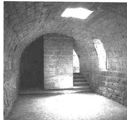
Interior del dipòsit medieval, trobat durant l'excavació arqueològica i restaurat. Foto: Jaume Soler. SPAL, 8.5.1990. A l'esquerra, nova coberta de la nau, que ha recuperat la forma original. Foto: Joan Francés. SPAL, 12.7.1990.
