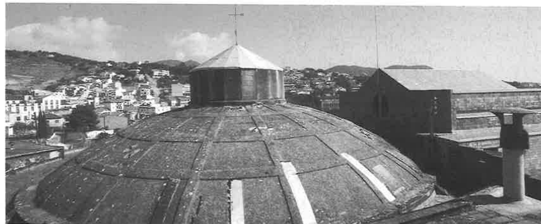
Exterior de la cúpula que cobreix la sala de butaques. Foto: M. Baldomà, SPAL, 16.3.1993.
