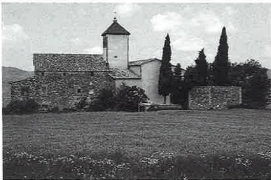
Façana de llevant de l'església, amb el cementiri annex, després de la intervenció. Foto: M. Baldomà. SPAL, 5.11.1992.
