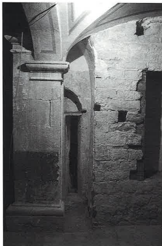
Parament sud de la nau, amb la porta romànica al fons, descoberta durant l'exclosió arqueològica del temple. Foto: Albert López, SPAL, febrer 1992.
