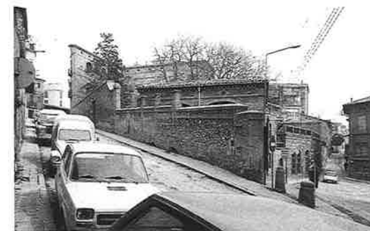
Façana i tanca del jardí de Can Puget, al carrer de la Baixada de la Fidela, abans de la restauració. Foto: Joan Francés, SPAL, 25.2.1985.
