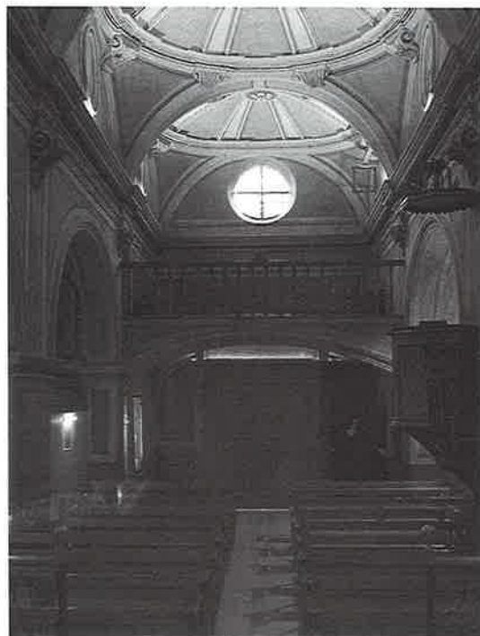
Sector de ponent de la nau, amb el cor elevat, després de les obres de restauració. Foto: M. Baldomà, SPAL, 25.6.1992. A la dreta, voltes barroques que cobreixen la nau, després de les obres de restauració. Foto: M. Baldomà, SPAL, 18.6.1992.
