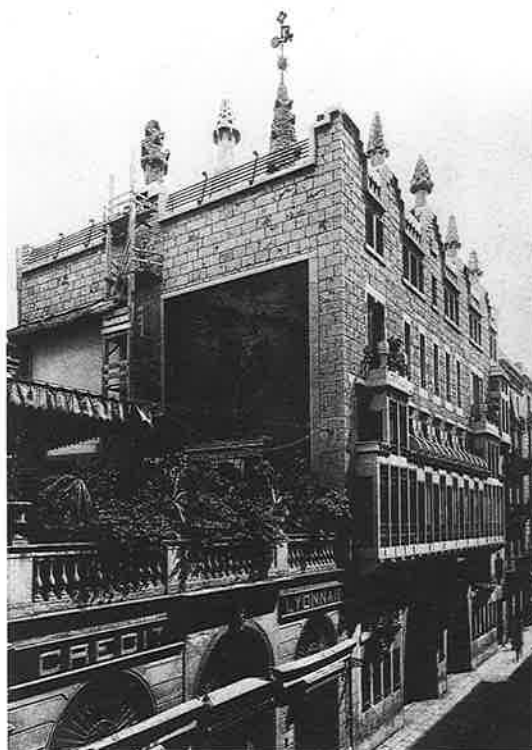
Façanes nord i est, poc després d'entllestar-se la construcció del palau. S'hi poden veure les pintures murals d'Aleix Clapés, ara desaparegudes. Foto: Biblioteca Nacional, Madrid. Cap al 1890.
