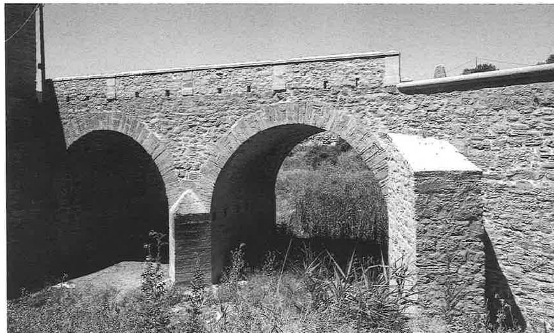
Façana del pont aigües amunt un cop restaurada la seva fàbrica. Foto: Joan Francés, SPAL, 6.7.1990.
