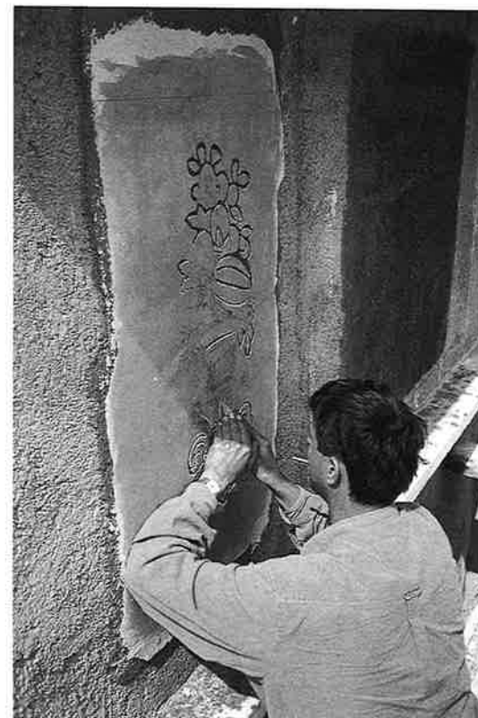
Procés d'execució dels nous esgrafiats que s'han afegit en la restauració de 1991-1993. Foto: Salvador Santolària, 5.5.1992. SPAL.
