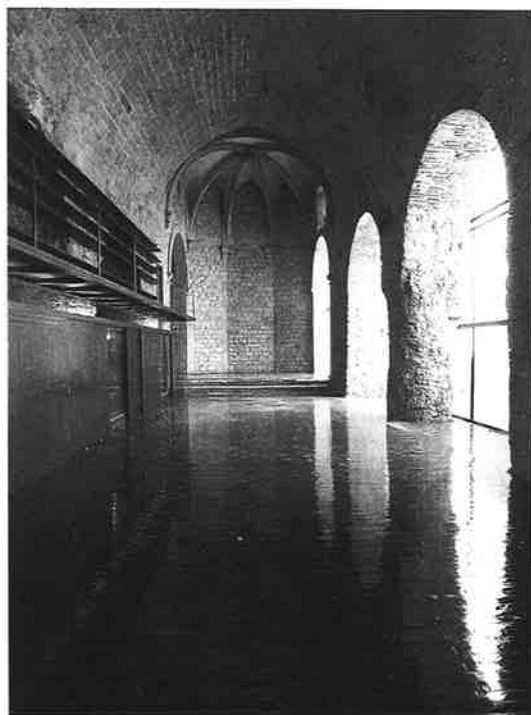
Interior de la nau després de la restauració. Fotos: M. Baldomà. SPAL (dalt, 18.2.1993; baix, 2.6.1992).
