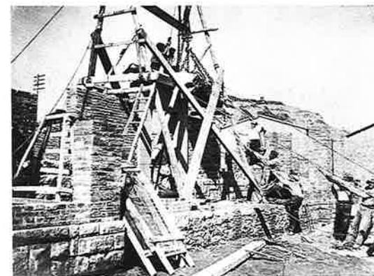
Fotografies de diversos moments del procés de construcció de les escoles Catalina Figueras, obra dirigida per l'arquitecte autor del projecte, Manuel Gausa. Fotos: Manuel Gausa, 1927. Col·lecció particular.
