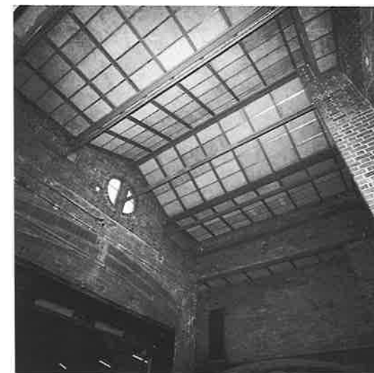
La coberta nova de l'escenari, un cop acabades les obres de restauració. Foto: Joan Francés, SPAL, 11.7.1990.
