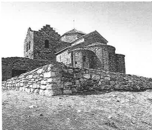
Vista del conjunt des del sud-est. En primer terme, un dels murets col·locats per contenir les terres. Foto: Jordi Isern, SPAL, 16.3.1990.
