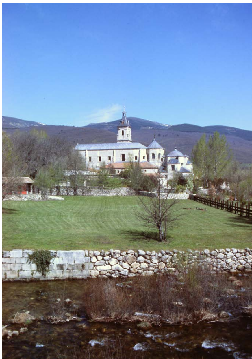
Figura 49. Eduardo Barceló, BAB Arquitectos. Monasterio de El Paular.
